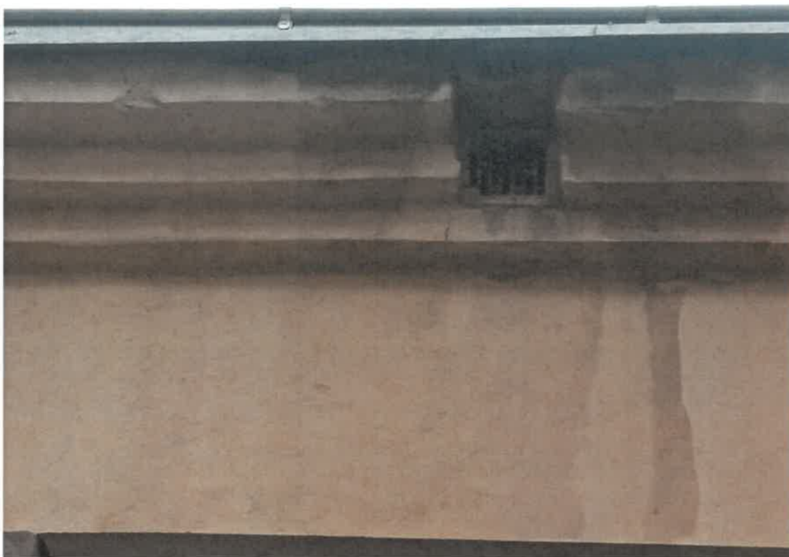
Część otworów wentylacyjnych zabezpieczona przed zasiedleniem przez ptaki
