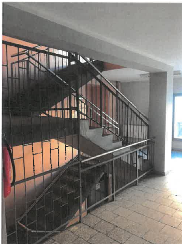
Fot. 5. - Klatka schodowa K1 - nieobudowana.
