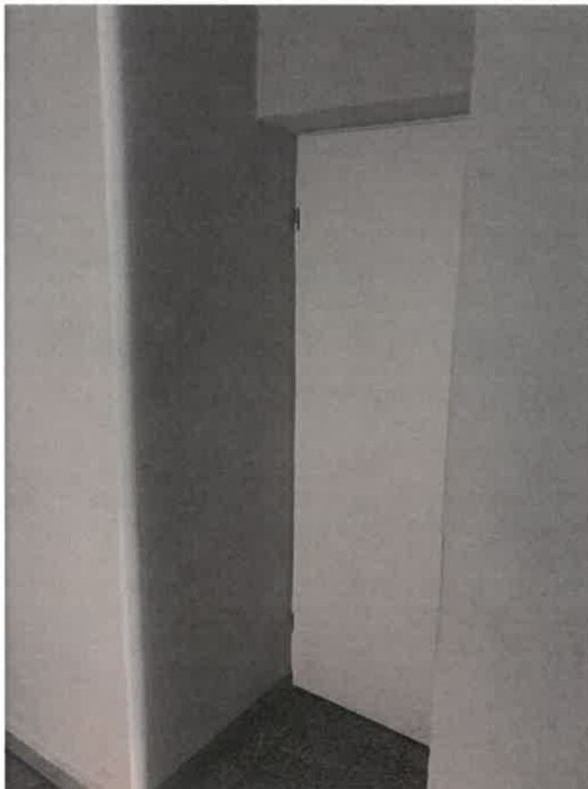
Fot. 11 - Brak możliwości poszerzenia otworów drzwiowych - wykonane pomiędzy pionami wentylacji.
