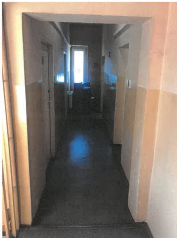
Fot. 9 - Zawężenie drogi ewakuacyjnej - w ciągu korytarza pom. 2.35.
