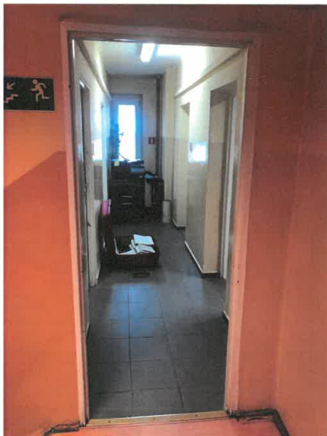
Fot. 8. - Przewężenie drogi ewakuacyjnej w ciągu korytarza - pom. 1.37
