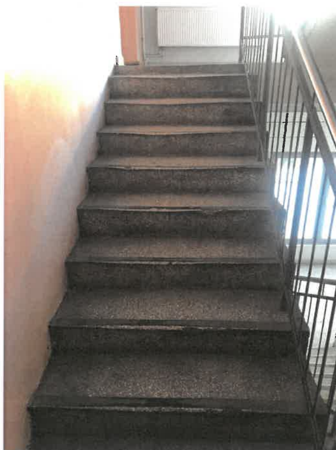
Fot. 6. - Klatka schodowa K1 - nieregularne stopnie schodowe (ostatni stopień wys. 7,5 cm).
