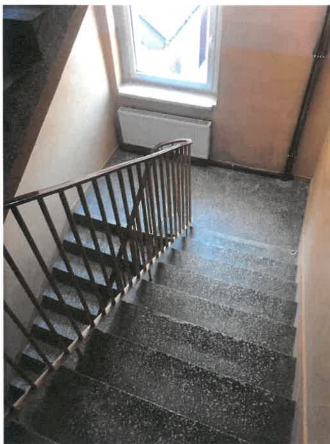
Fot. 12 - Klatka schodowa K2 - zawężenie szerokości spoczników.
