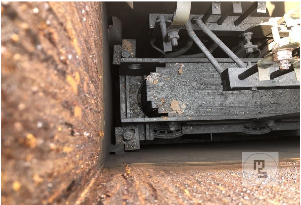
Fot. 9 Wnętrze, stan zachowania
