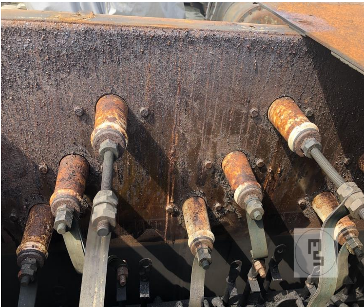
Fot. 6 Wnętrze, stan zachowania
