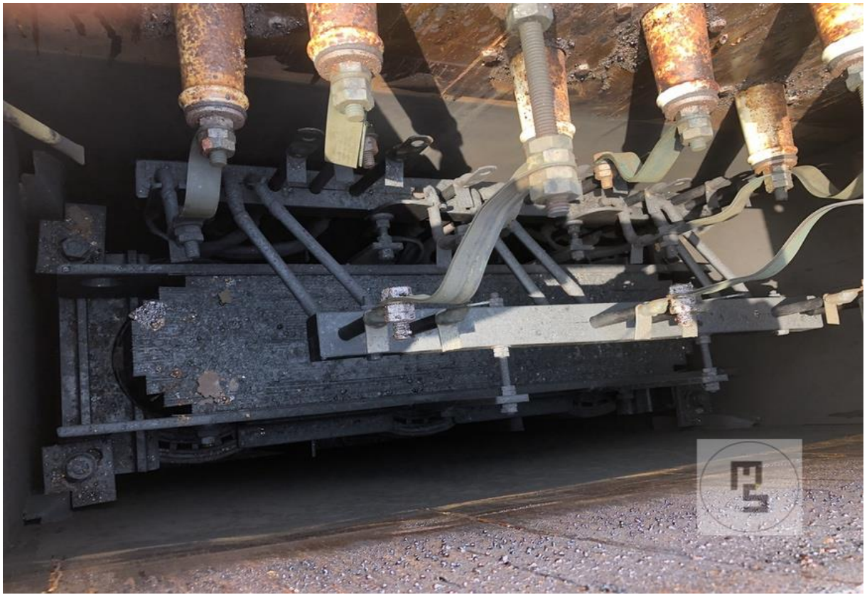
Fot. 8 Wnętrze, stan zachowania
