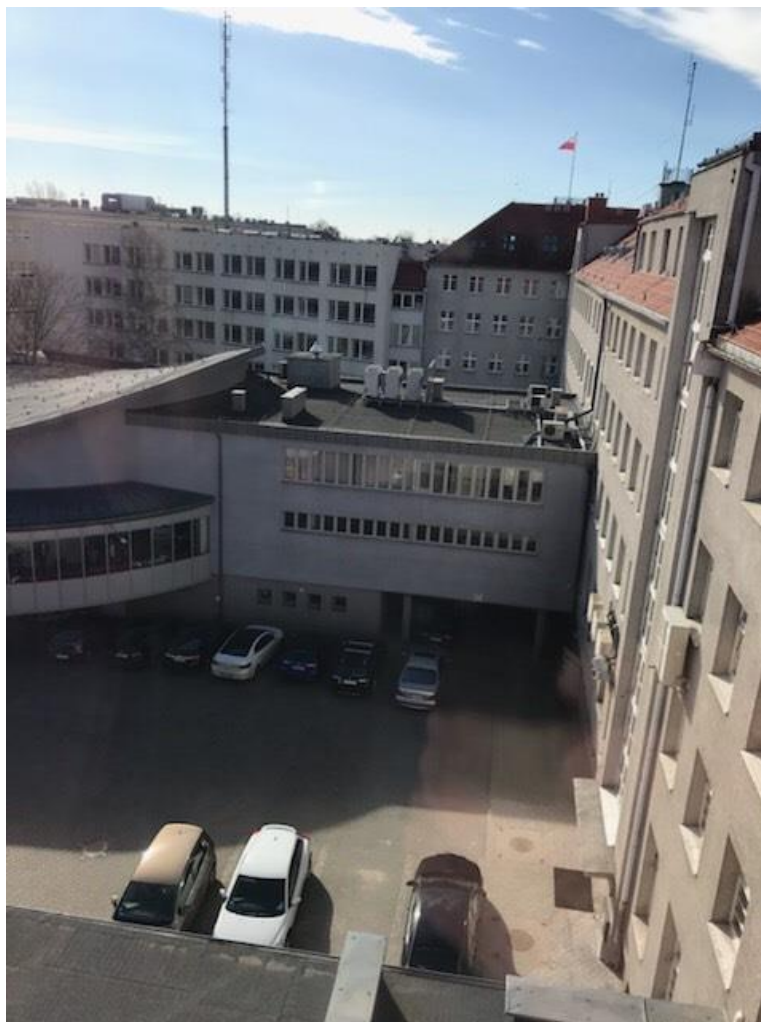
Fot. 1 Widok na dach
