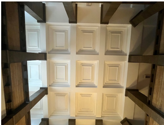
Fotografia nr 3 – kasetony na suficie hallu
