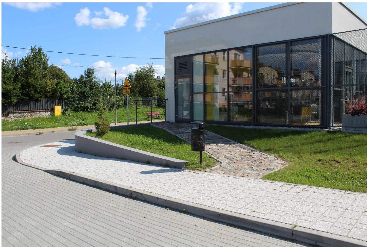
Fot. 3. Widok na tył budynku Mediateki.
