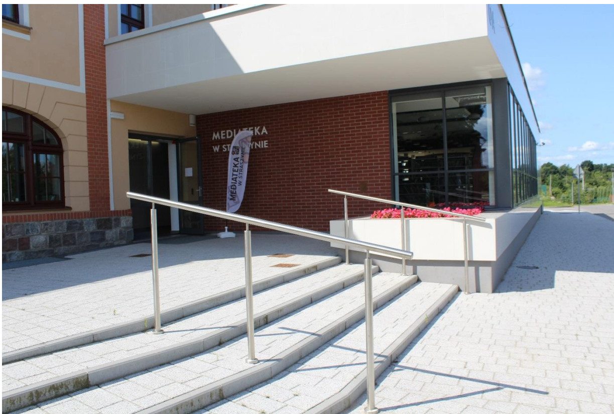
Fot. 5. Widok front budynku Mediateki i podniesioną rabatę.
