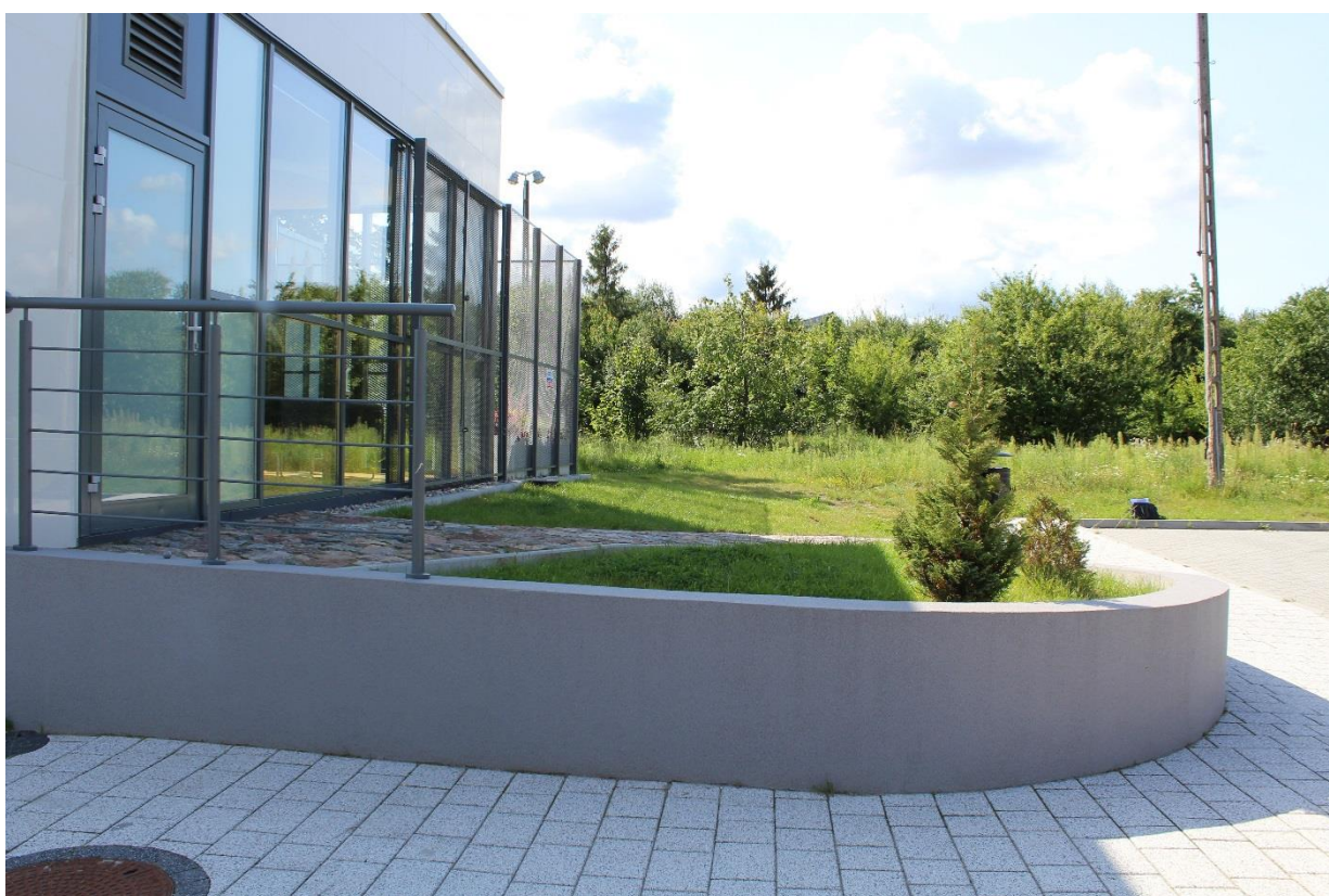
Fot. 4. Widok na tył budynku Mediateki.
