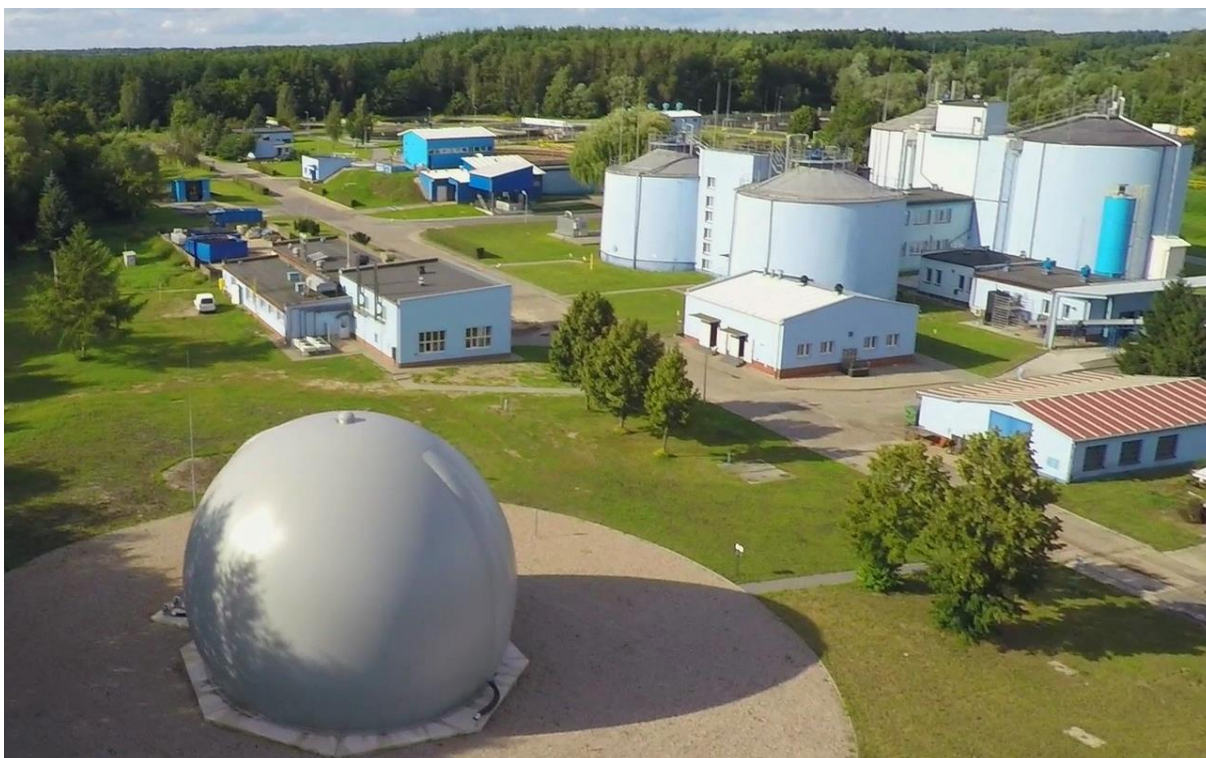
Rysunek 19 Klasyczne komory fermentacji mokrej V=9\ 200\ m^3 ze zbiornikiem biogazu 1\ 600\ m^3 – oczyszczalnia w Słupsku 360 000 RLM Analizując rynek lokalnych bioodpadów i osadów ściekowych można przyjąć, że potencjał energetyczny instalacji fermentacji w oczyszczalni ścieków w Słupsku w produkcji biogazu wynosi ok. 2,6 mln Nm^3 /rok , co przy 60% zawartości CH_4 daje wartość energetyczną w paliwie gazowym ok. 15 GWh . Uwzględniając sprawność CHP to szacowana produkcja energii elektrycznej jest na poziomie 6 GWh/rok , podobna też jest produkcja energii cieplnej. Ilość odpadów do produkcji energii może się jeszcze zwiększyć, a dysponowanie lokalną instalacją będzie stymulowało prawidłowe postawy przedsiębiorstw w myśl modelu GOZ.
