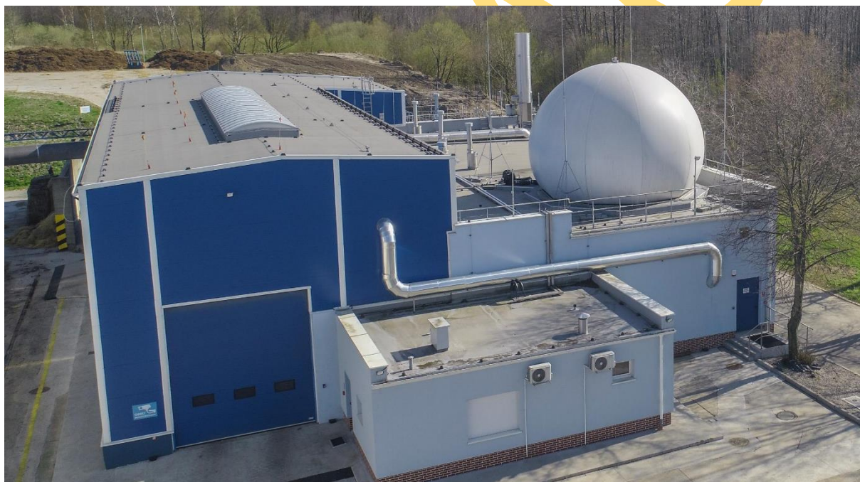
Rysunek 17 Instalacja fermentacji perkolacyjnej dla biodopadów w OŚ w Słupsku
