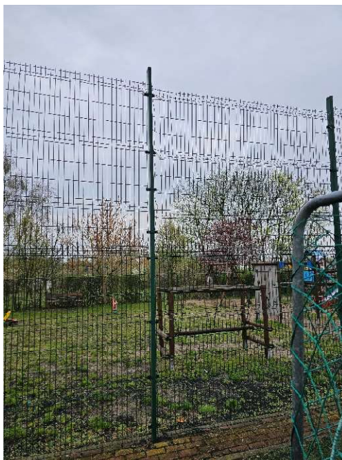
Fotografia 6. Wymiana (demontaż oraz montaż) paneli ogrodzeniowych.
