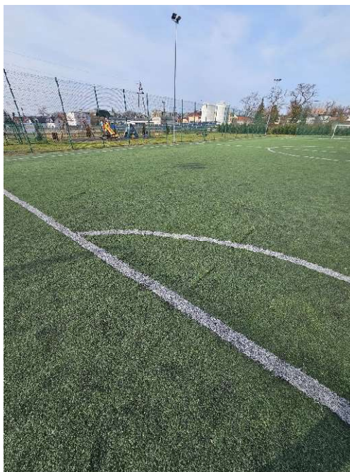
Fotografia 1. Rozwarstwiona trawa syntetyczna na boisku do piłki nożnej.
