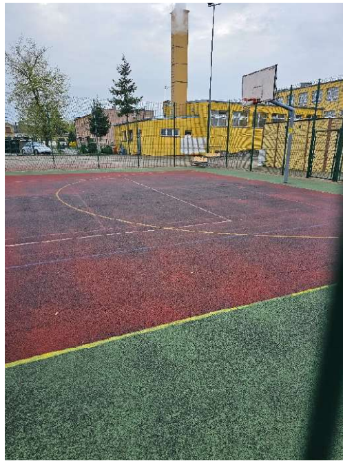
Fotografia 3. Istniejąca nawierzchnia boiska wielofunkcyjnego.
