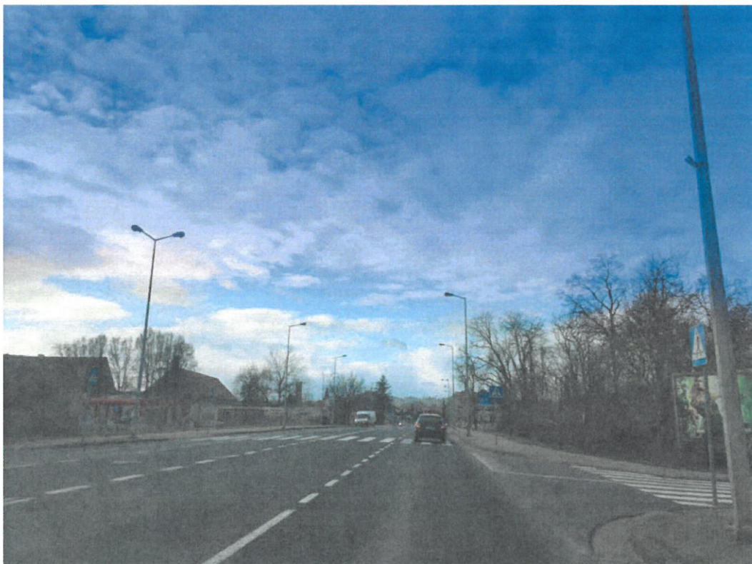
Fot. 8 Przejście dla pieszych w rejonie skrzyżowanie ulic Wrocławska / Dąbrówki / V Dywizji Piechoty (widok w kierunku Centrum)
