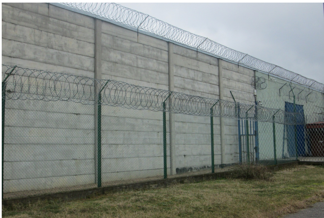
Fot. nr 1 - Istniejąca linia ogrodzenia wewnętrznego do przebudowy - strona wschodnia
