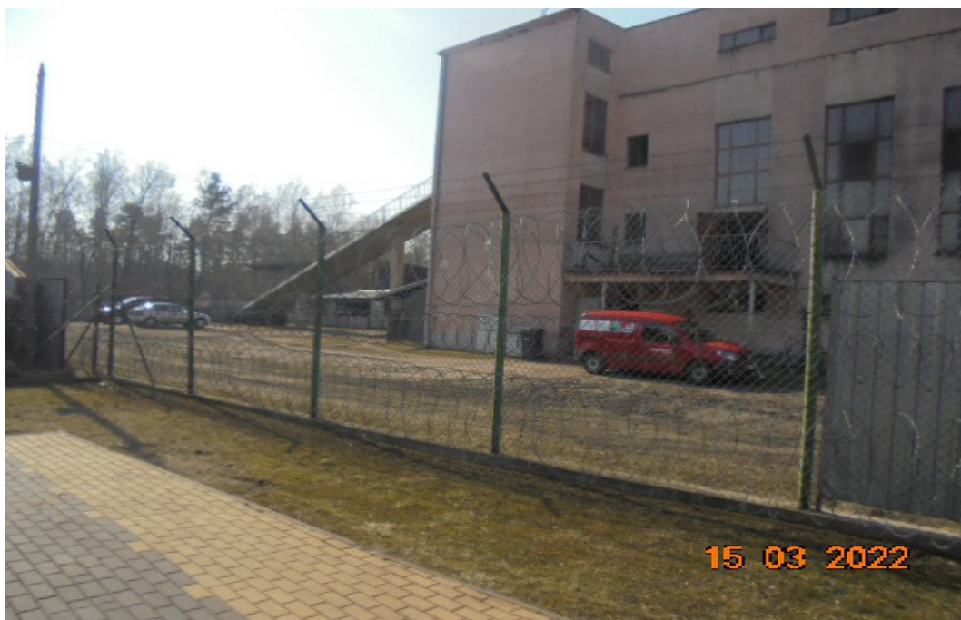
Fot. nr 4 - Istniejące ogrodzenie – strona zachodnia
