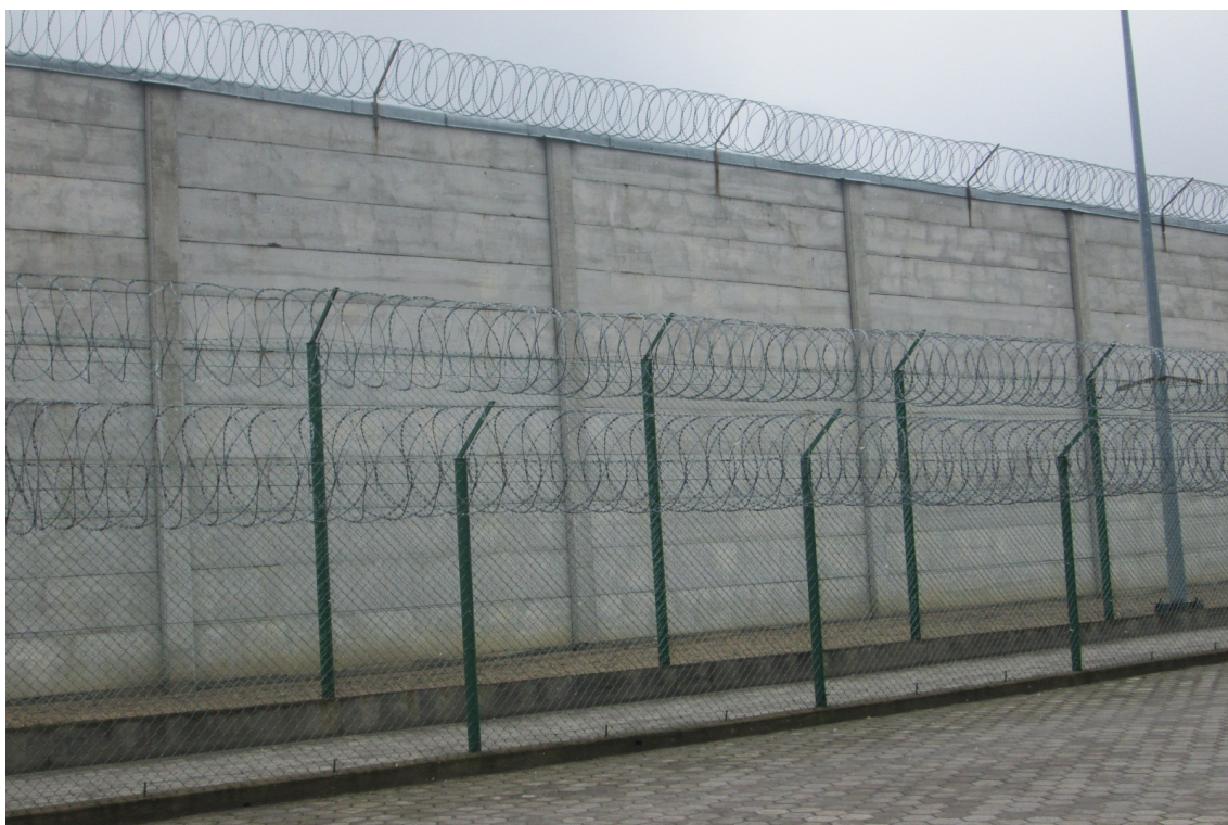
Fot. nr 2 - Istniejąca linia ogrodzenia wewnętrznego do przebudowy - strona południowa
