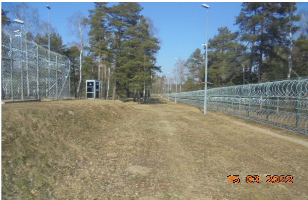
Fot. nr 2 - Istniejące ogrodzenie – strona północno-wschodnia – lokalizacja budowy nowego ogrodzenia na odcinku około 18 mb
