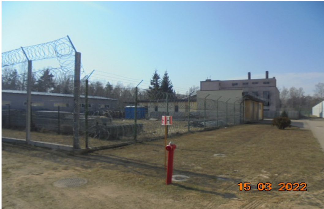
Fot. nr 3 - Istniejące ogrodzenie – strona południowa
