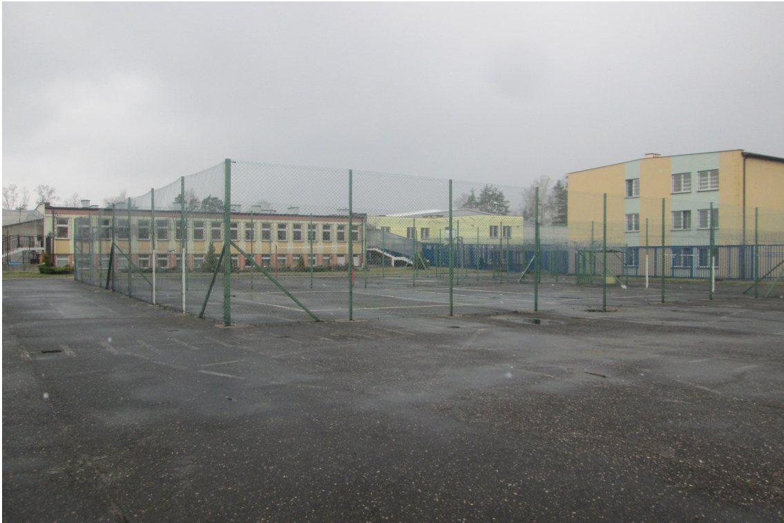
Fot. nr 6 - Istniejące boisko na terenie ścisłym - do przebudowy
