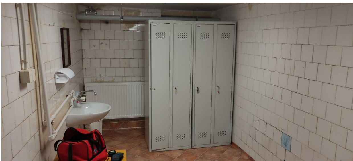
Fot. 1 Pomieszczenie gospodarcze
