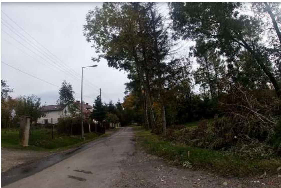
Zdj. nr 3 Środkowa część projektowanego odcinka
