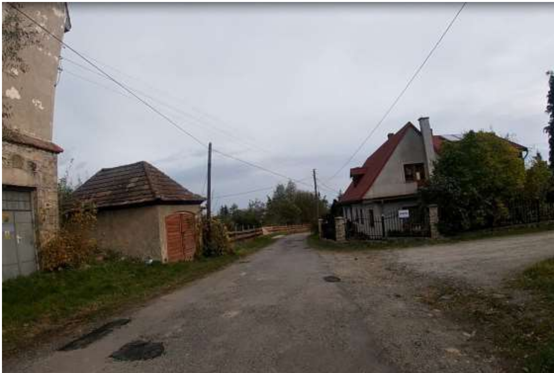
Zdj. nr 2 Początkowy odcinek drogi
