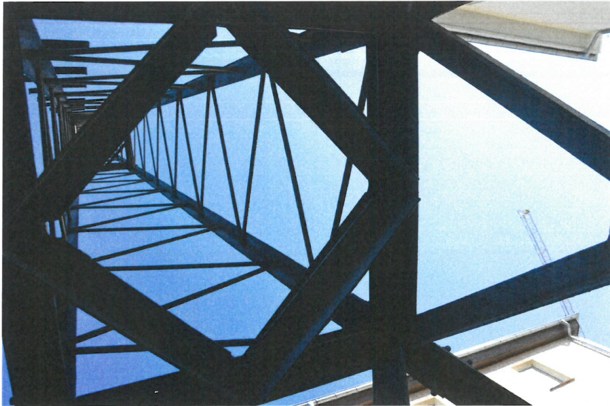
Fot. 9. Przepona wieńcząca segment 1.
