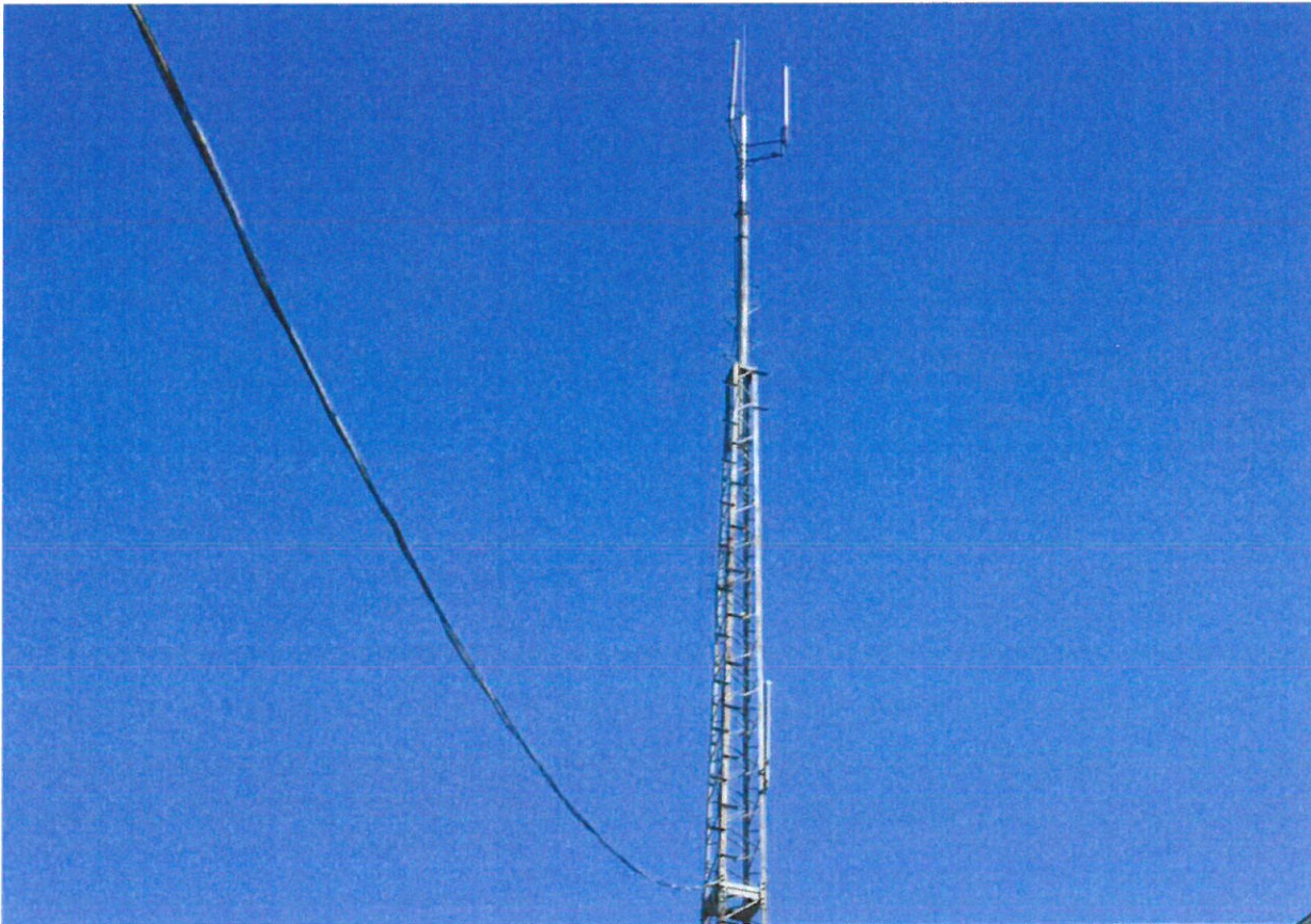
Fot. 10. Wyposażenie wieży, pozostałości okablowania, przewód doprowadzony do budynku
