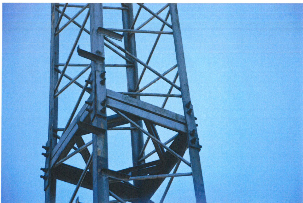
Fot. 7. Połączenie zakładkowe segmentu 2. z segmentem 3. Widoczne stopnie komunikacyjne
