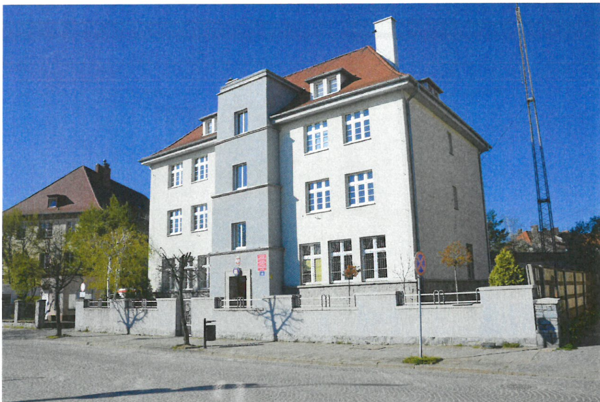
Fot. 1. Widok na działkę 68/4 od strony frontowej (z ulicy Mickiewicza). Widoczny budynek PSSE Strzelin. Na drugim planie wieża antenowa przeznaczona do rozbiórki
