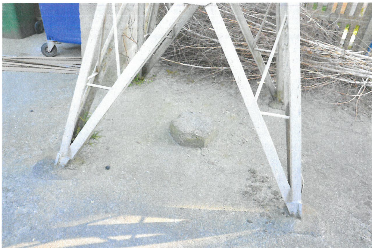
Fot. 5. Segment 1 – przyziemie
