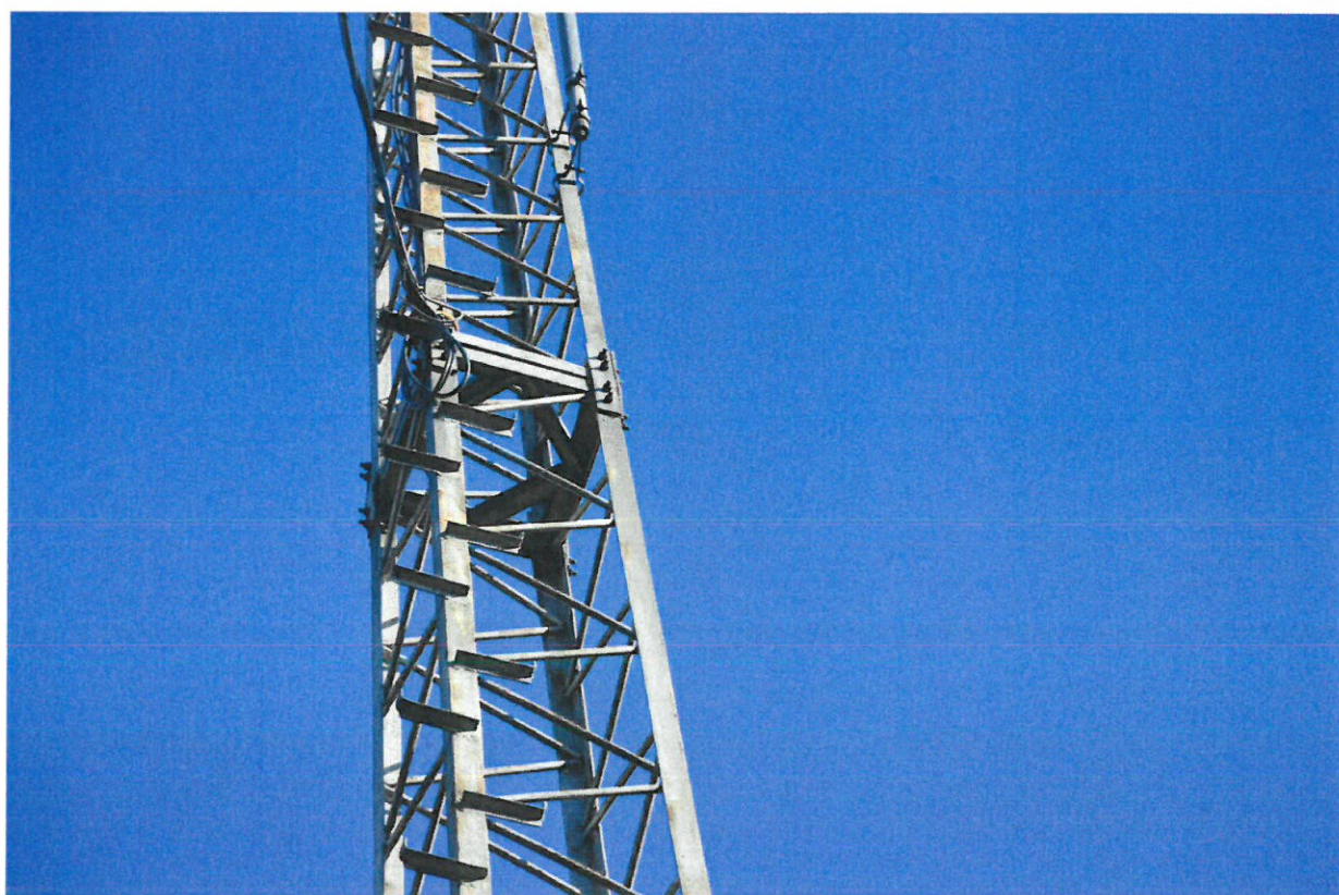
Fot. 8. Połączenie zakładkowe segmentu 3. z segmentem 4. Widoczne stopnie komunikacyjne
