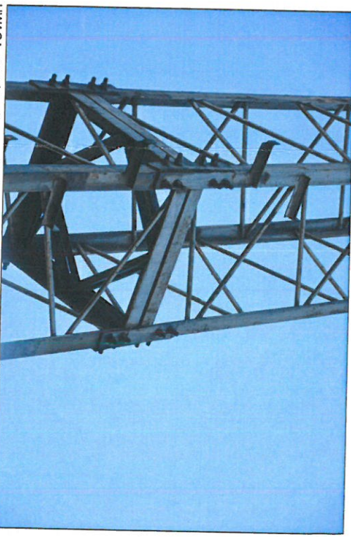
DETAIL 2* - POŁĄCZENIE SEGMENTÓW
