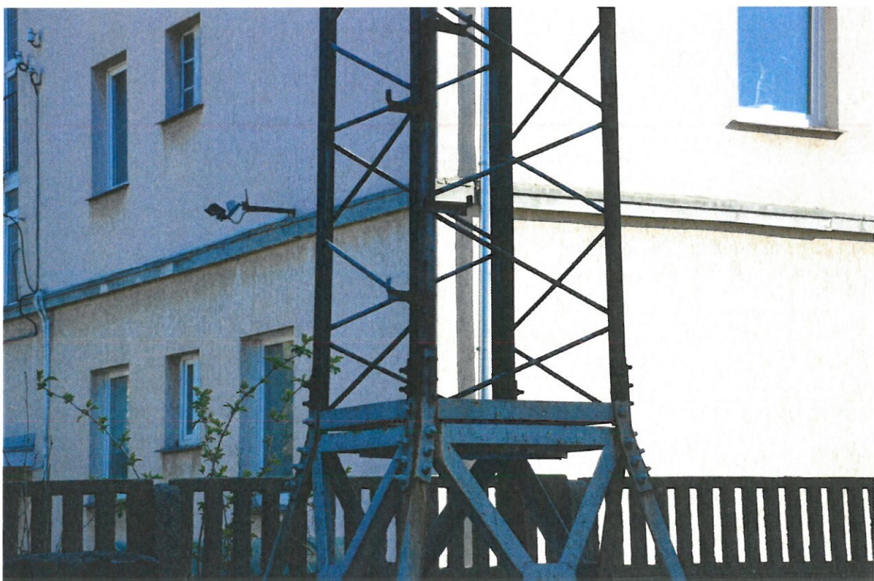
Fot. 6. Połączenie zakładkowe segmentu 1. z segmentem 2. Widoczne stopnie komunikacyjne
