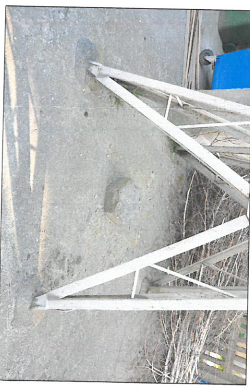
DETAIL 1* - POŁĄCZENIE WIEŻY Z FUNDAMENTEM
