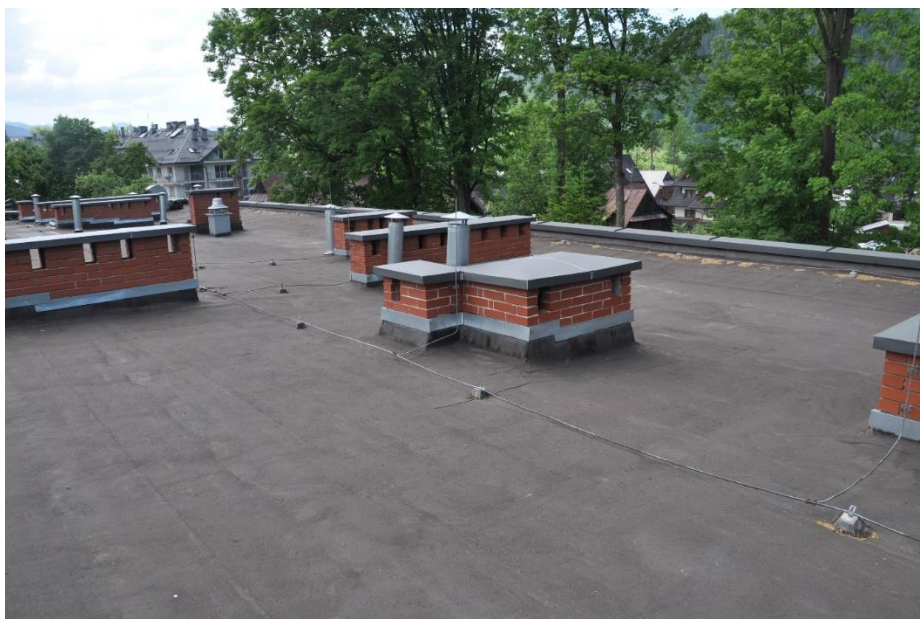
Fot. 2. Ogólny widok dachu od strony południowo wschodniej
