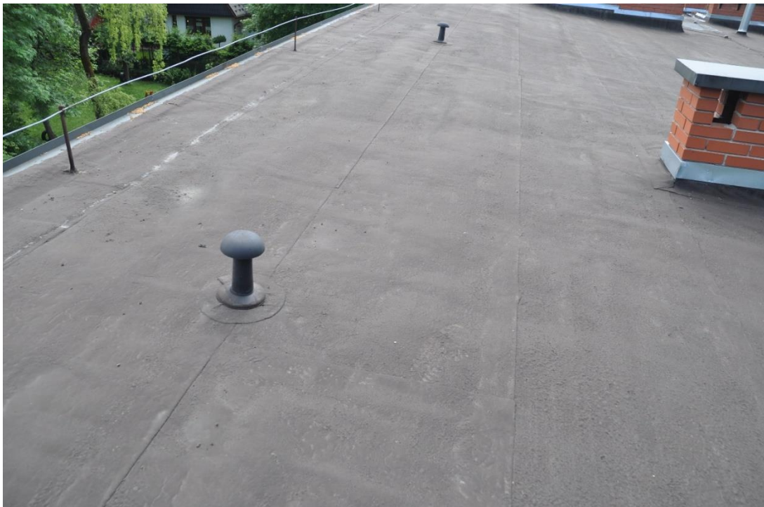
Fot. 4. Kominki odpowietrzające pokrycie dachowe, widoczne „purchle” powietrzne
