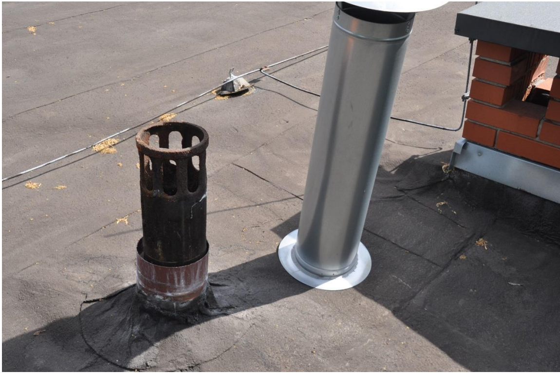
Fot. 9. Przejście i uszczelnienie pionów odpowietrzających
