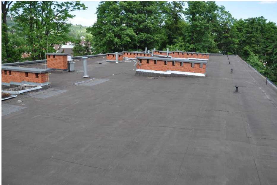
Fot. 1. Ogólny widok dachu od strony południowo zachodniej
