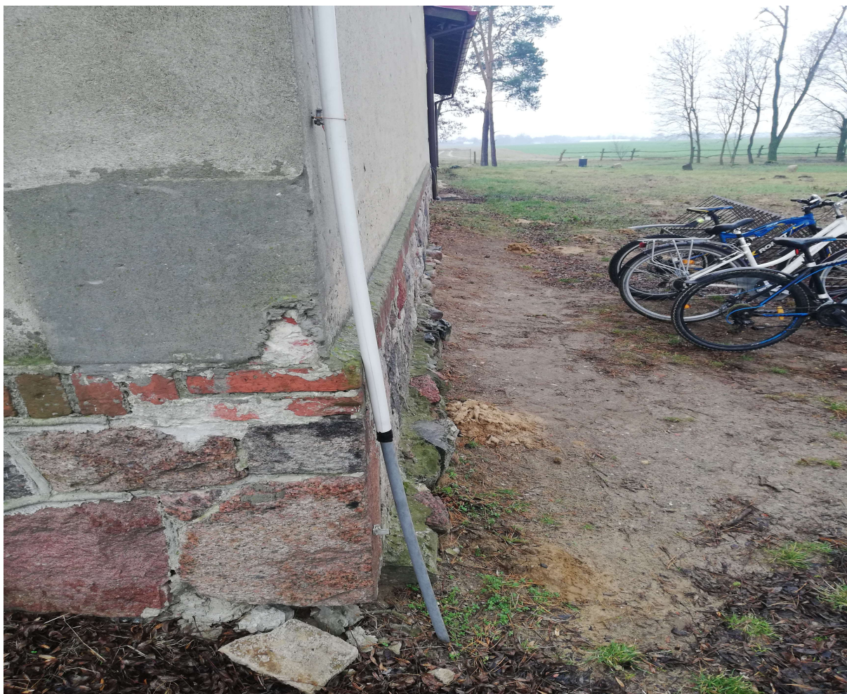
Zdjęcie ukazujące ubytki i nierówności cokołu kamiennego.
