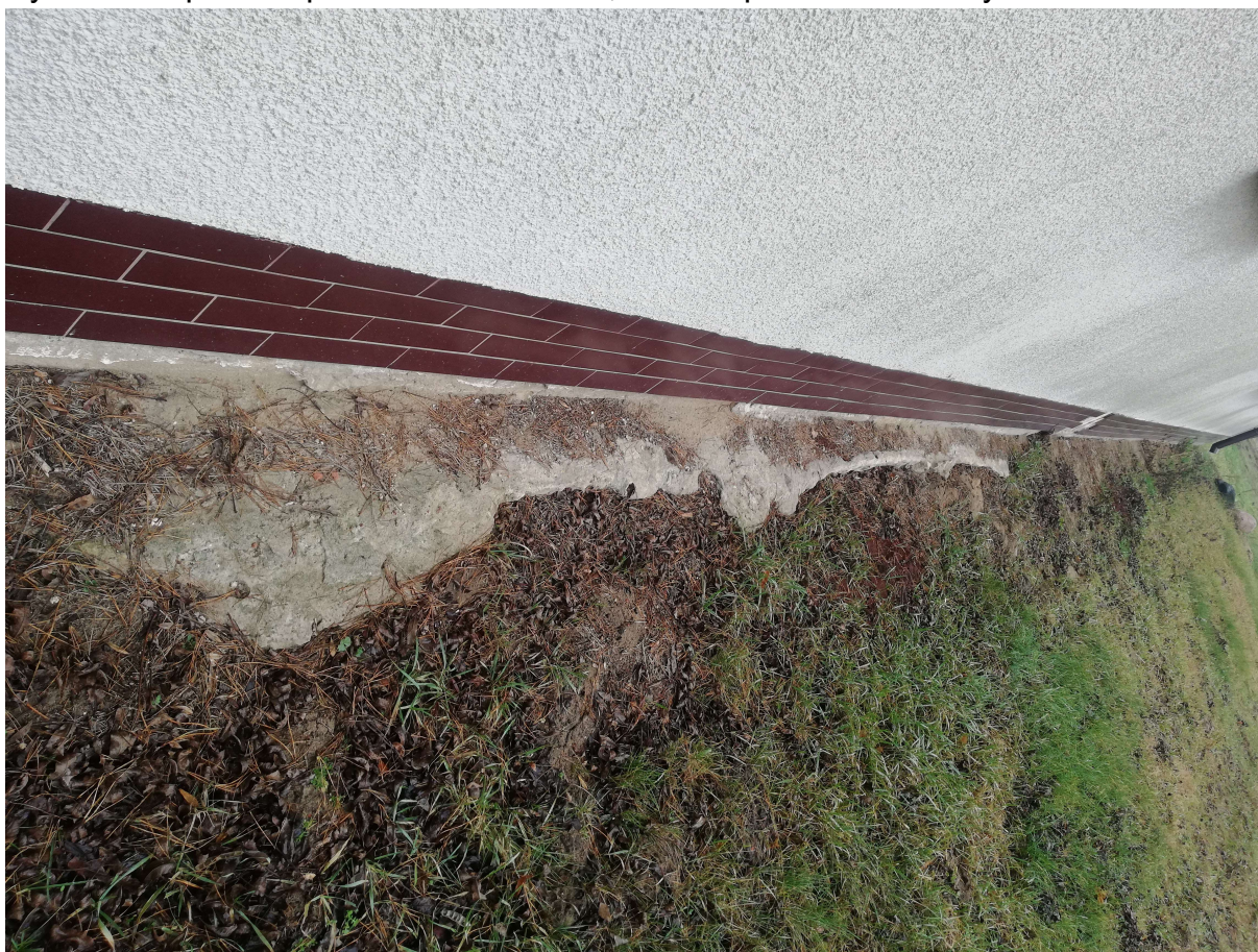
Zdjęcie ukazujące odpadające płytki klinkierowe i niestaranne wykonanie ław fundamentowych na części dobudowanej
