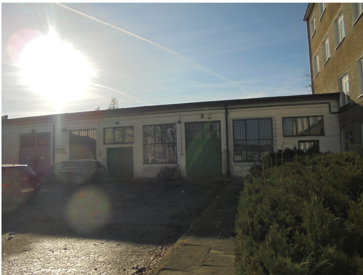
Ryc. 4. Budynek warsztatowo-ślusarski Łany 6
