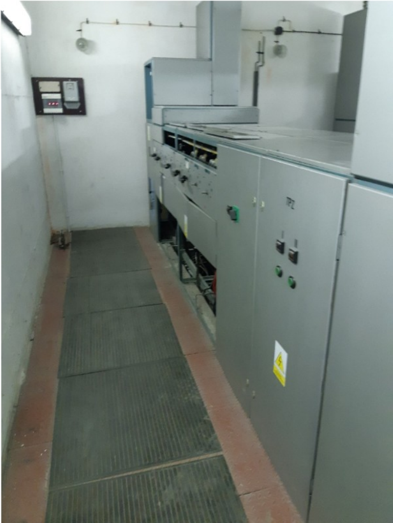
Załącznik nr 1 – zdjęcia z modernizowanego pomieszczenia
