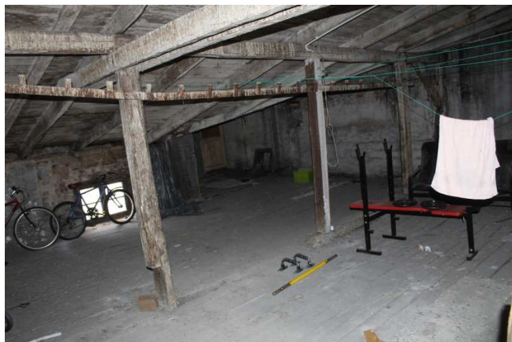
Zdjęcie nr 7 – uzupełnić spód słupka oraz podłożyć podwalinę
