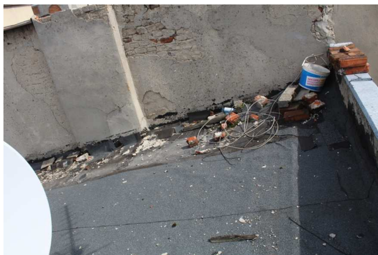
Zdjęcie nr 1 – zalegający gruz na poszyciu dachowym.
