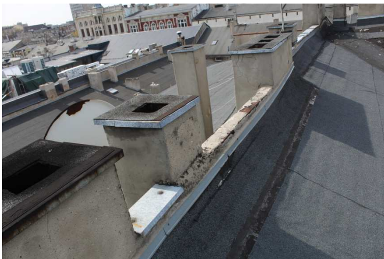
Zdjęcie nr 3 – wykonać obróbkę attyki z blachy tytan-cynk.
