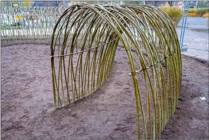
TUNELE TWORZONE SĄ Z ELEMENTÓW WERTYKALNYCH Z WZMOCNIENIEM NA SKRZYŻOWANIU KILKU PĘDÓW, USTABILIZOWANE PODŁUŻNYMI ELEMENTAMI PO DŁGACH ORAZ NA SZCZYCIE TUNELU
