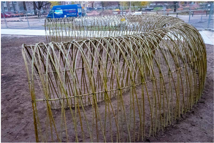
TUNELE TWORZONE SĄ Z ELEMENTÓW WERTYKALNYCH Z WZMOCNIENIEM NA SKRZYŻOWANIU KILKU PĘDÓW, USTABILIZOWANE PODŁUŻNYMI ELEMENTAMI PO DŁGACH ORAZ NA SZCZYCIE TUNELU
