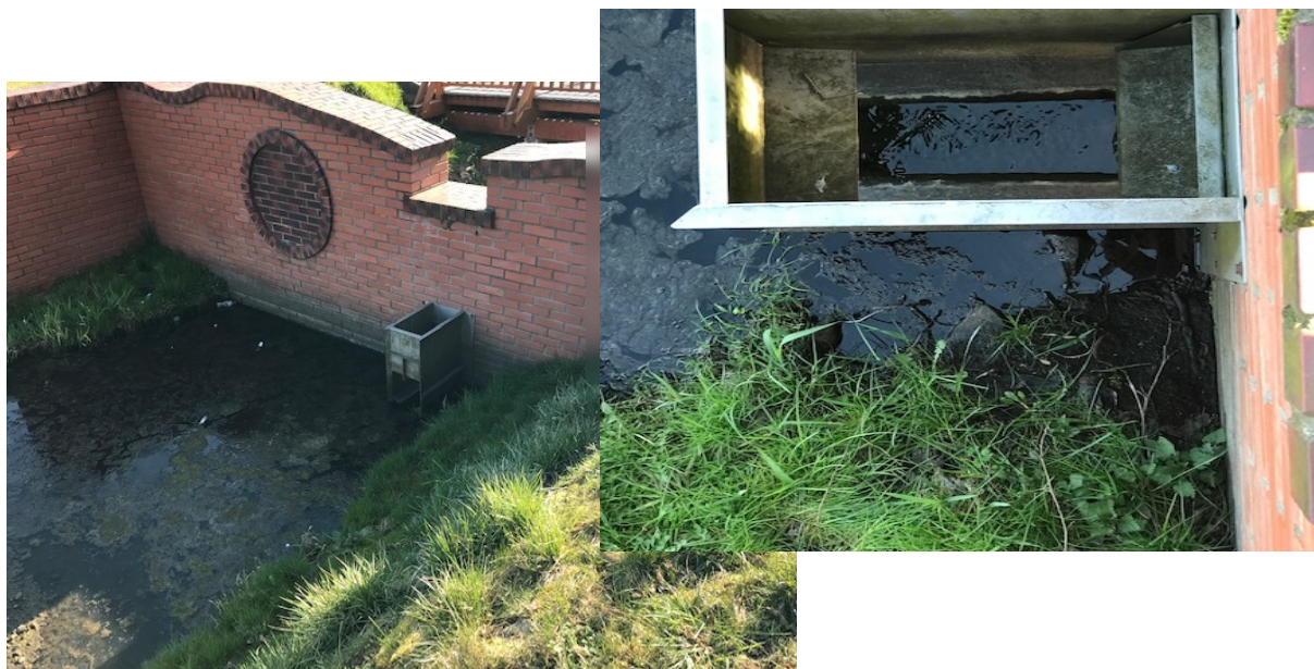
Fot. 1. Regulator przepływu (widok od strony napływu wód deszczowych - po lewej), widok z góry (po prawej) [źródło: D. Folehr]
