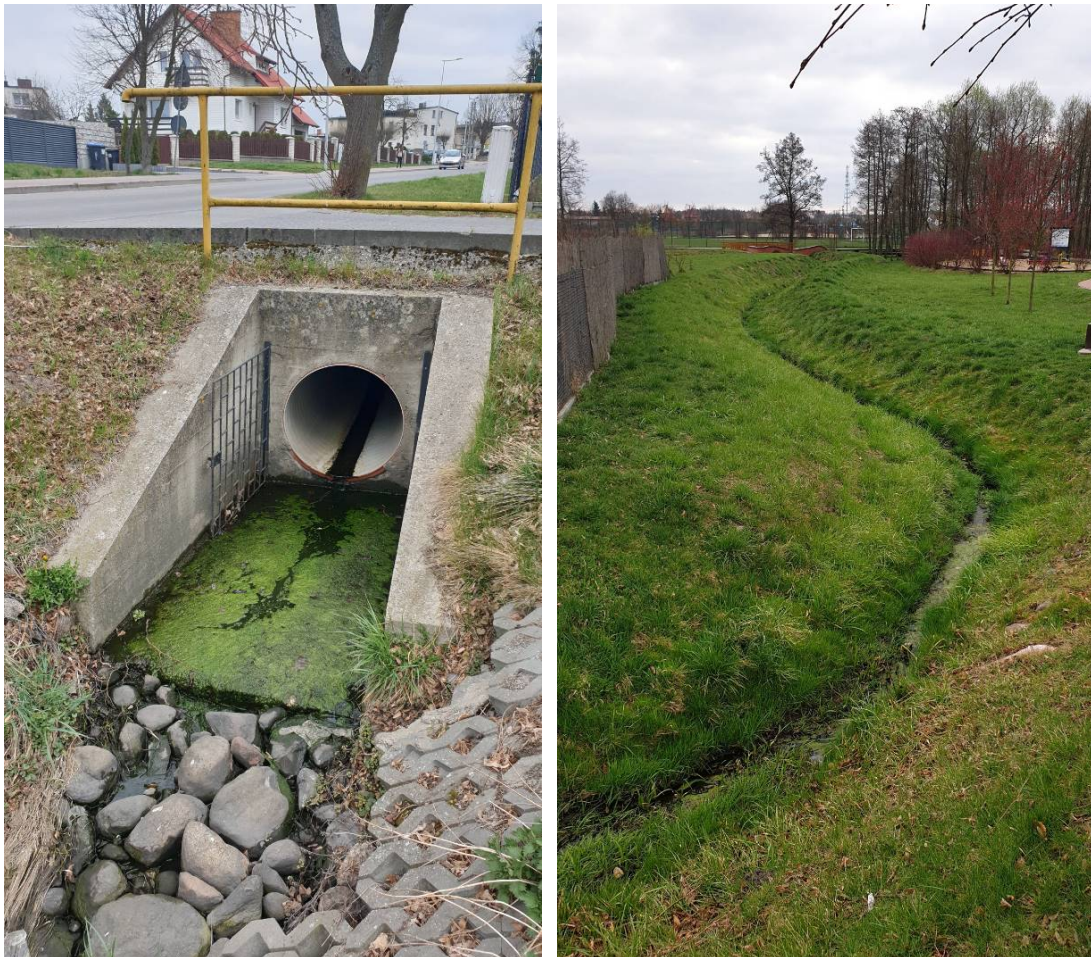
Fig. 6. Istniejący wylot betonowy \varnothing 1000 mm (z lewej) oraz część odcinka rowu melioracyjnego (z prawej) przeznaczone do likwidacji
