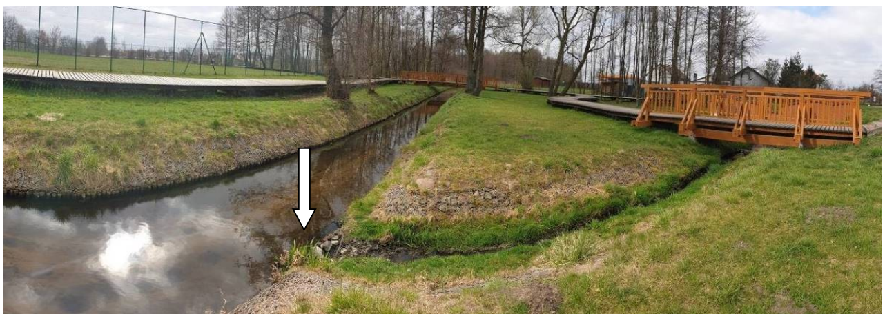
Fig. 2. Istniejący wylot rowu odprowadzającego wody deszczowe do Czerskiej Strugi
