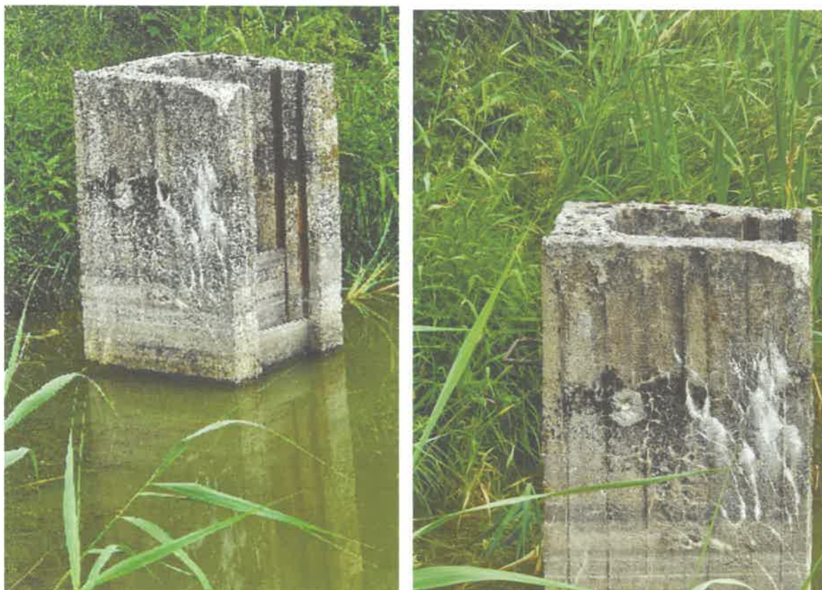
FOTO 4. Mnich żelbetowy – stan istniejący
