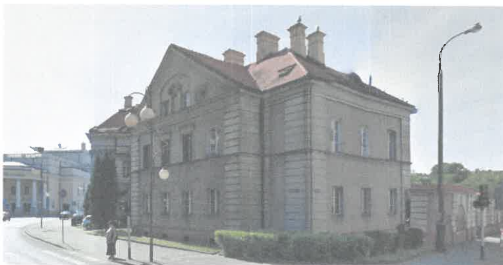
Zdj. 3. Budynek b. Banku Poskiego w Kaliszu, obecnej siedziby Banku Gospodarstwa Krajowego – Oddział w Kaliszu – 2017r. (prawe skrzydło - plac Bogusławskiego/ul. Bankowa)
