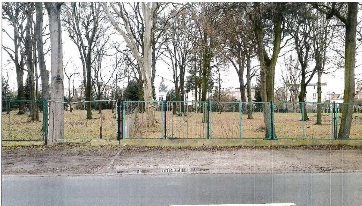
Fragment ogrodzenia przeznaczona do demontażu.
