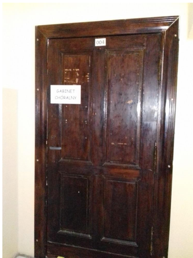
Fot.22 drzwi do gabinetu chóralnego w kondygnacji piwnicznej – prawdopodobnie jedyne zachowane drzwi z oryginalną kolorystyką .
