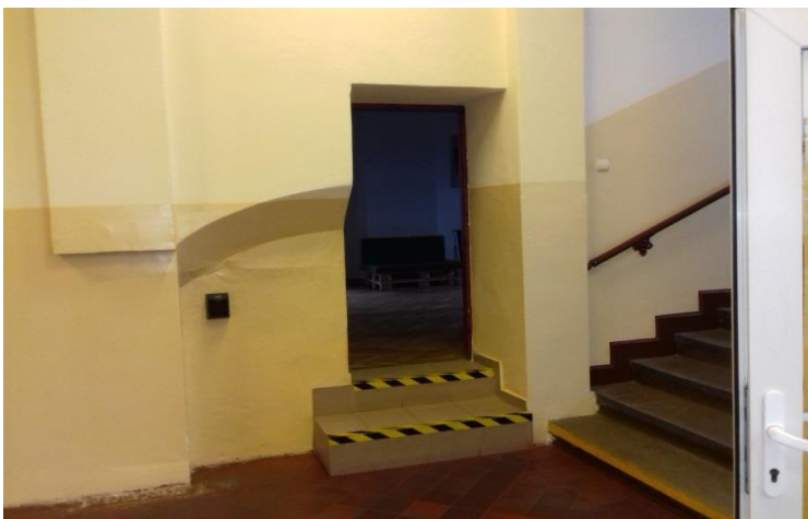
Fot.11 klatka schodowa K1, zamurowanie otworu drzwiowego , odtworzenie niszy , likwidacja stopni schodowych .
