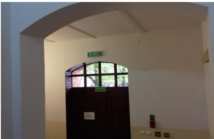
Fot.12 klatka schodowa K1,K3 odsłonięcie detalu architektonicznego w obrębie drzwi wejściowych w przyziemiu. Oczyszczenie listew drewnianych na suficie .
