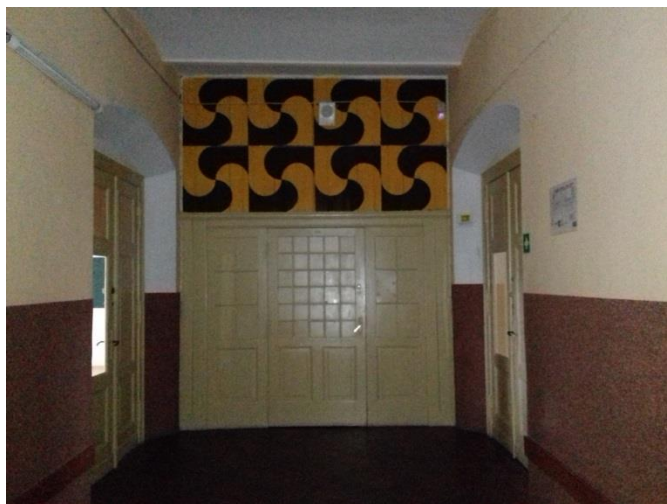
Fot.19 Zdekompletowana witryna na korytarzu na I-piętrze , dawne przejście pomiędzy obydwoma częściami szkoły , brakujące nadświetle zrekonstruować , witrynę przywrócić do stanu oryginalności .
