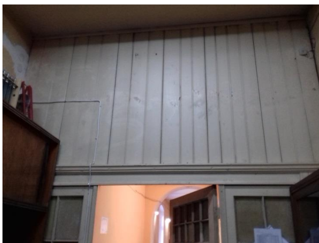
Fot.20 Zdekompletowana witryna na korytarzu na I-piętrze , zdjęcie zrobione od strony pomieszczenia , w miejscu nadświetla p[rzepierzenie wykonane z desek .
