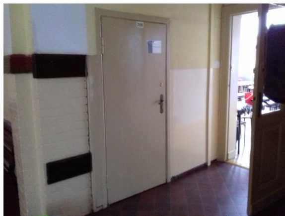
Fot.16 Drzwi nie oryginalne do wymiany w pom. nr 208 na II-pietrze, w ich miejscu zamontować drzwi pochodzące z demontażu w sali komputerowej
