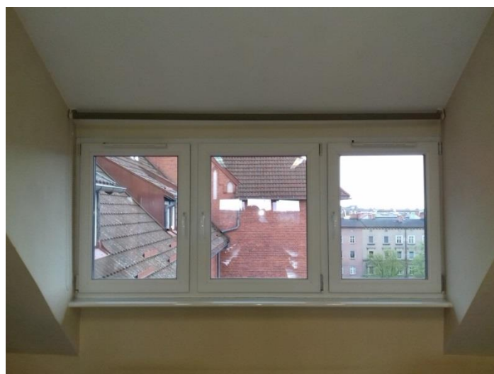
Fot. 29 Poddasze, okna pcv w złym stanie technicznym w pomieszczeniu nr 306 , okna bez przynależnych rolet , nawiewniki w skrzydłach – stolarka do renowacji .
