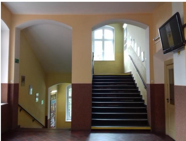
Fot.9 klatka schodowa K3 na I-piętrze , fragmenty ceglanego muru zostały otynkowane a następnie pokryte gramoplastem .
