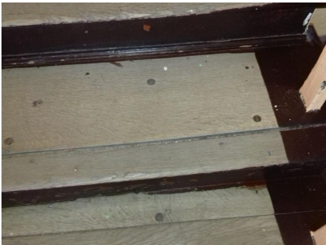
Fot.16 klatka schodowa K4 , uszkodzone stopnie schodowe do wymiany .
