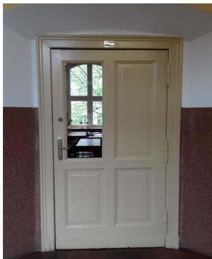
Fot.1 Typowe drzwi z ościeżnicą występujące w przeważającej ilości , w okresie późniejszym wyjęto górną płycinę w celu doświetlenia pomieszczeń .
