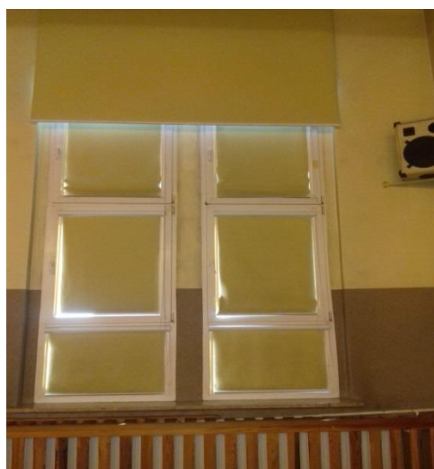
Fot. 25 Okna pcv na auli , okna poddać renowacji , rolety są mocno zużyte , do wymiany , kolor ustalić z zamawiającym.
