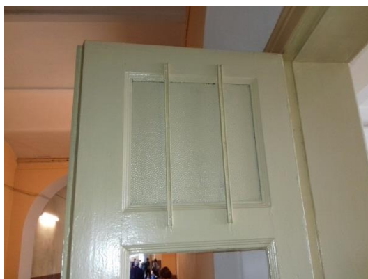
Fot.9 Drzwi wysokie – drugi typ drzwi , występujący w ilości 4 szt. zamalowane nadświetla w górnej części skrzydeł z elementami metalowymi należy przywrócić do stanu oryginalnego.
