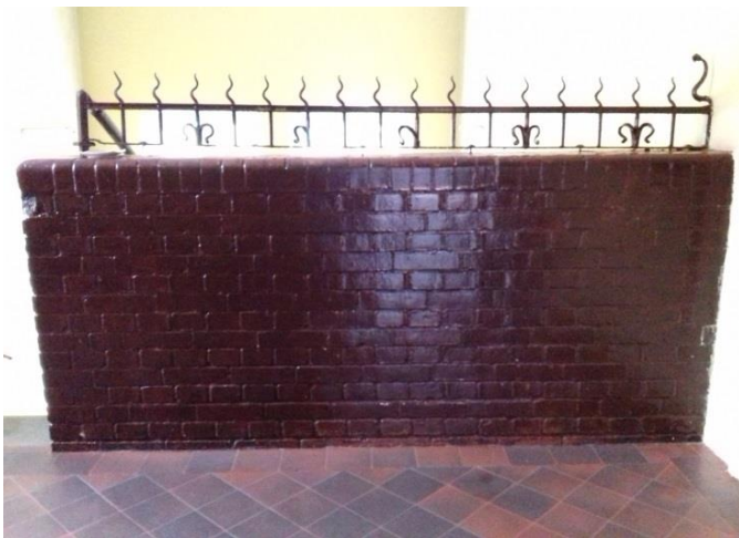
Fot.2 klatka schodowa K3 detal metaloplastyczny (płotek) do renowacji. Mur ceglany oczyścić z nawarstwień powłok malarskich .
