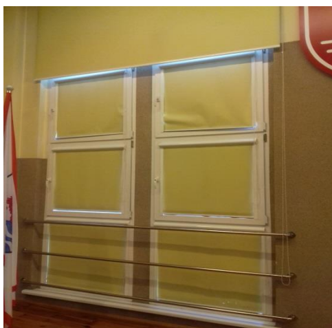
Fot. 24 Aula , widok okien pcv z roletami do renowacji od strony podestu. Podest na poziomie parapetu , zabezpieczenie okien poziomymi poprzeczkami .
