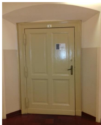
Fot.6 Typowe drzwi z ościeżnicą występujące na parterze ,drzwi kompletne (bez wyjętej płyciny) występują w pomieszczeniach administracyjnych i magazynowych.
