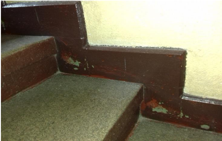
Fot.10 klatka schodowa K1,K3 oczyszczenie z nawarstwień farb i brudu granitowych stopni schodowych oraz cokolików przysściennych.
