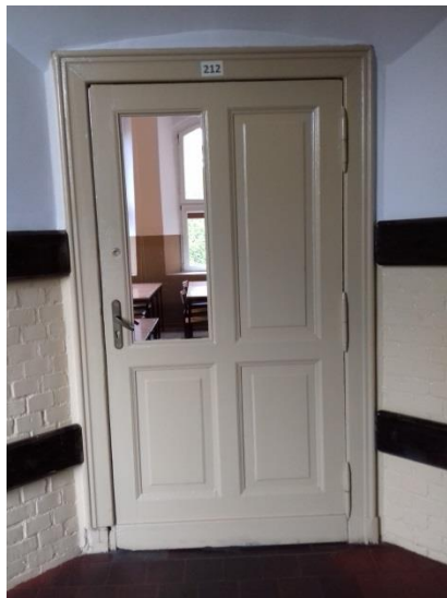
Fot.5 Typowe drzwi z ościeżnicą występujące na II-piętrze .
