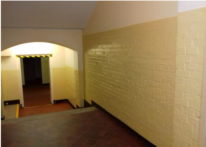
Fot.13 klatki schodowe K1,K3 , ściany ceglane pomalowane farbą olejną- przywrócić ścianę do pierwotnego wyglądu.
