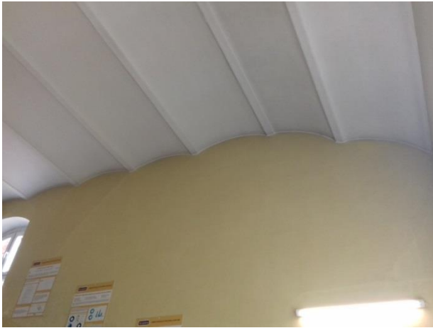
Fot.7 klatka schodowa K3, widok sufitu i ścian na ostatniej kondygnacji drewniane listwy maskujące belki stalowe zostały pokryte nawarstwieniami farb , na ścianie widoczne są włoskowate zarysowania w obrębie podparcia belek stalowych.
