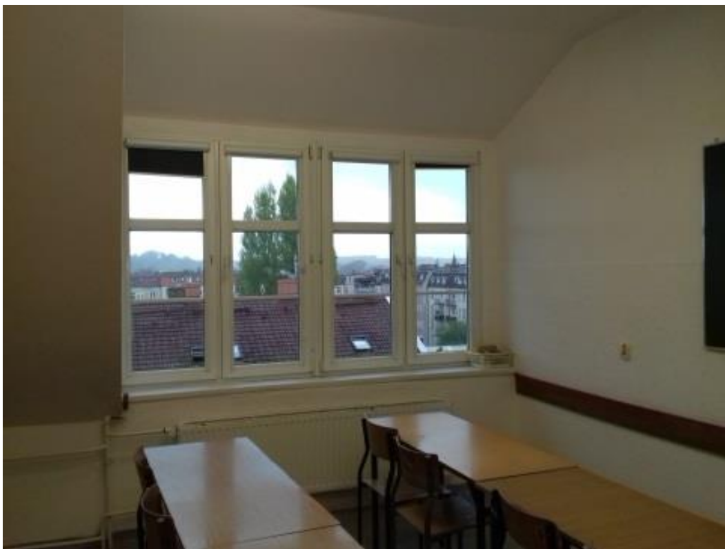
Fot. 30 Poddasze, okna pcv w złym stanie technicznym w pomieszczeniu nr 304 , okna z roletami – stolarka do renowacji , rolety do wymiany.
