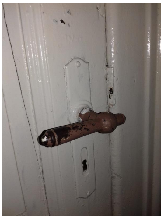
Fot.23 kondygnacja piwniczna – prawdopodobnie jedyna oryginalna zachowana klamka z szyldem – dobierając nowe elementy zamykające należy wziąć pod uwagę podobne rozwiązanie .
