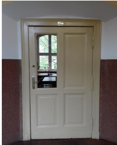
Fot.4 Typowe drzwi z ościeżnicą występujące na różnych kondygnacjach. Wyjęta górna płycina i przeszklenie występuje tylko w pomieszczeniach dydaktycznych.
