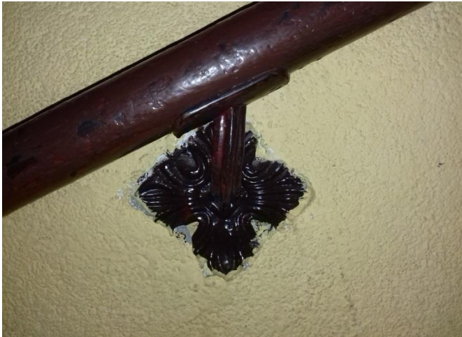
Fot.1 klatka schodowa K1,K3 detal metaloplastyczny pochwyty do renowacji.
