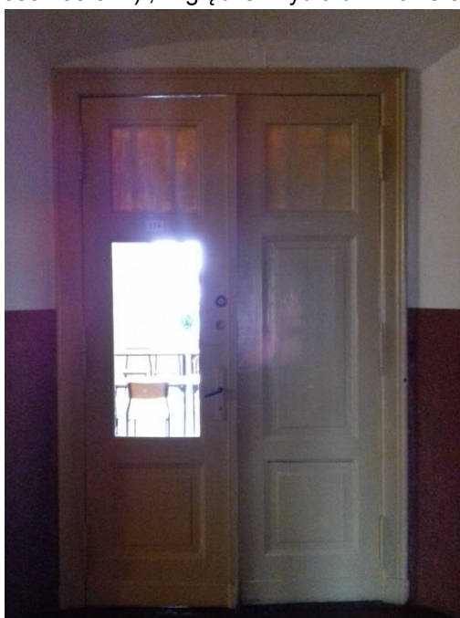
Fot.8 Drzwi wysokie – drugi typ drzwi . występujący w ilości 4 szt . w budynku , w okresie późniejszym wyjęto górną płycinę w celu doświetlenia pomieszczeń .
