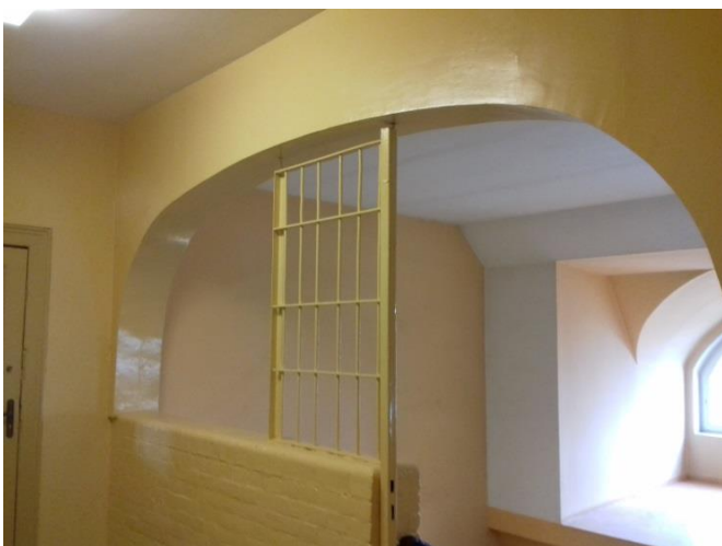
Fot. 17 klatka schodowa K4 na poddaszu , uczyszczenie ceglanego muru z nawarstwień farb , likwidacja wtórnej kraty , montaż szklanej szyby pomiędzy murem a nadprożem.
