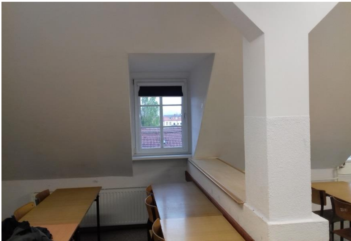
Fot. 31 Poddasze, okna pcv w złym stanie technicznym w pomieszczeniu nr 304 ,pojedyncze okno z roletą – stolarka do renowacji , roleta do wymiany.
