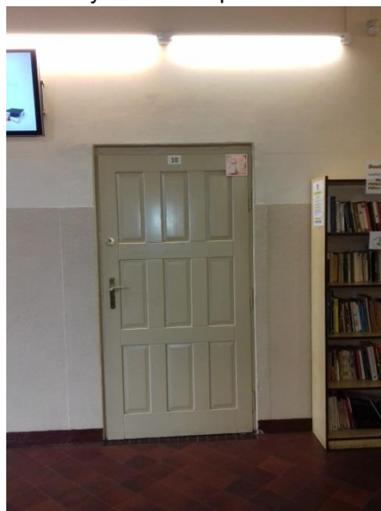
Fot.18 Drzwi nie oryginalne na parterze do biblioteki przewidziane do wymiany , w ich miejscu zamontować drzwi pochodzące z demontażu z pracowni komputerowej na I-piętrze .
