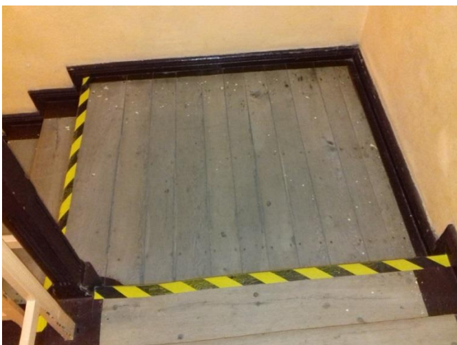
Fot. 18 klatka schodowa K4 spocznik pokryty deskami sosnowymi .
