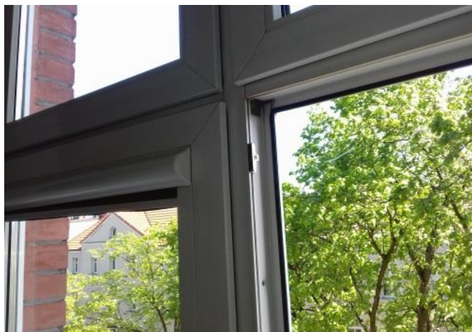
Fot. 27 Okna pcv w złym stanie technicznym w pomieszczeniach dydaktycznych na II-piętrze , okna zakwalifikowano do wymiany , widoczne połączenie słupka z poprzeczką oraz kaseta na roletę .
