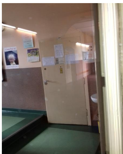
Fot.17 Drzwi nie oryginalne do wymiany w pom. nr 116a na I-pietrze, w ich miejscu zamontować nowe drzwi drewniane wykonane na podstawie zachowanych oryginałów .
