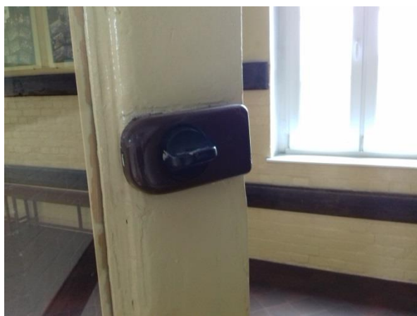
Fot.14 Różne sposoby zamykania drzwi- zamki z wkładka patentową
