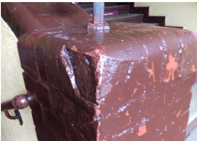
Fot.3 klatka schodowa K3, uszkodzenie muru ceglanoego , mur oczyścić z nawarstwień powłok malarskich , uszkodzenia uzupełnić.
