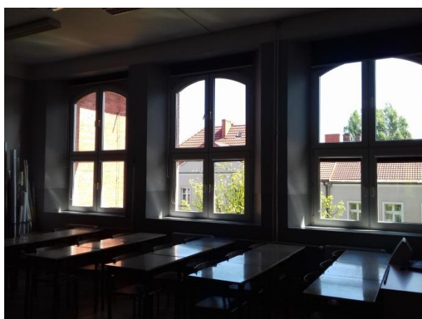
Fot. 26 Okna pcv w złym stanie technicznym w pomieszczeniach dydaktycznych na II-piętrze , okna zakwalifikowano do wymiany .
