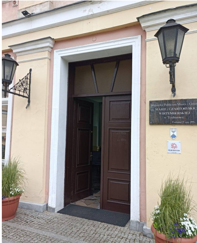
Rys. 1 Wejście główne do pałacu.
