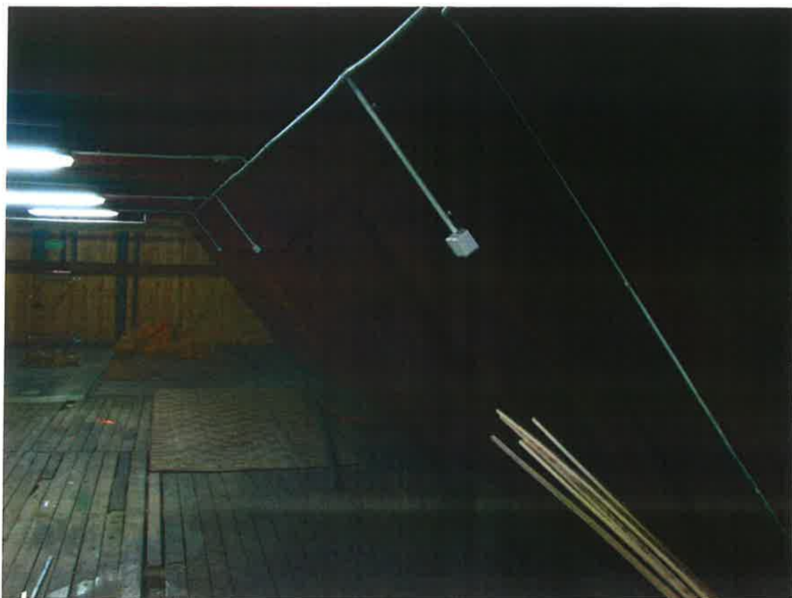
Fot. 5. Widok konstrukcji dachu
