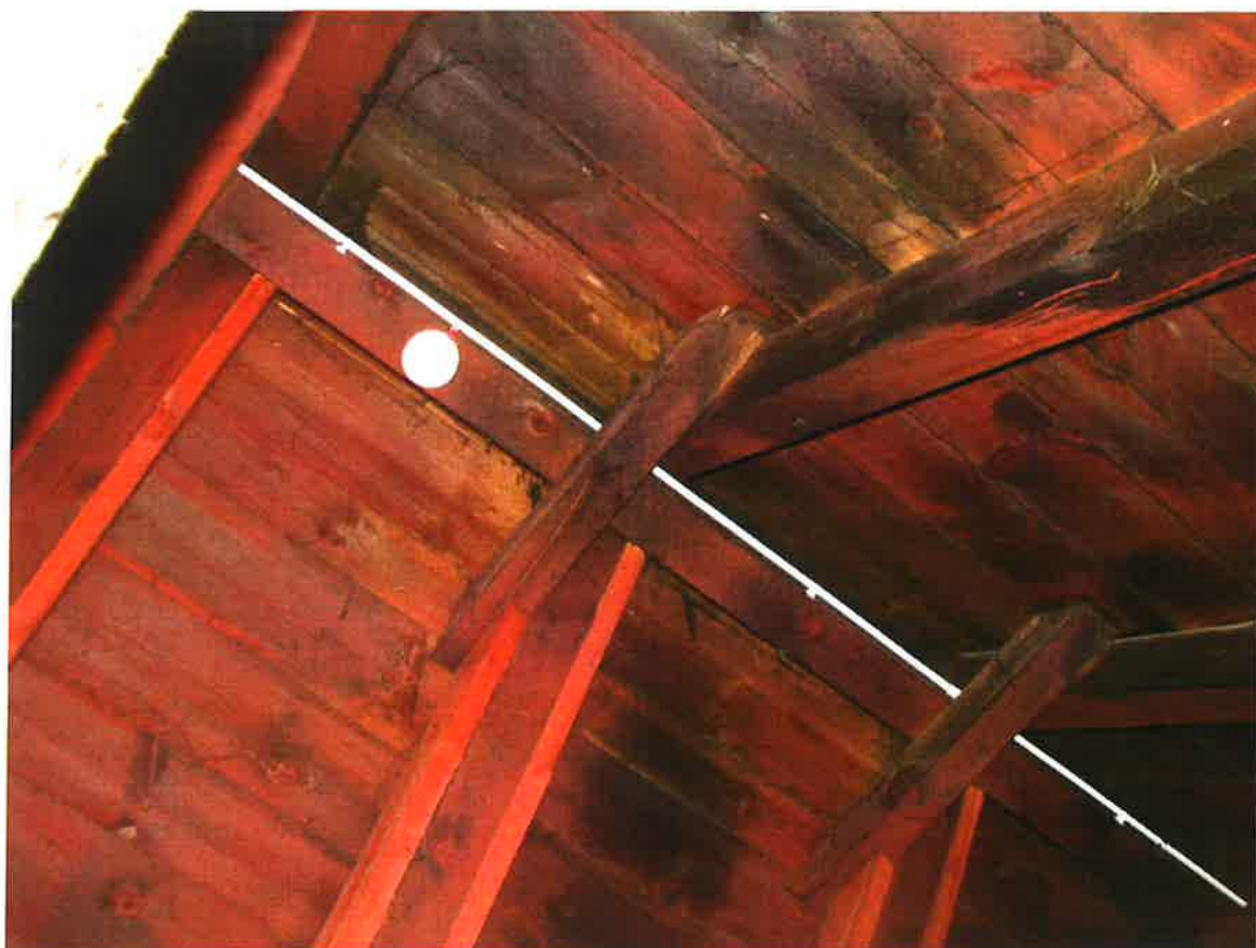
Fot. 6. Widok konstrukcji dachu
