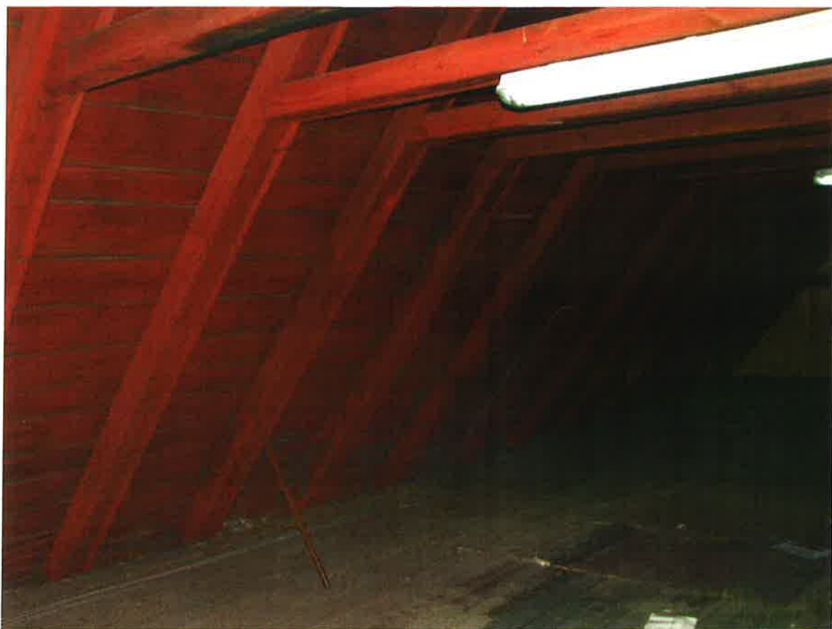
Fot. 4. Widok konstrukcji dachu
