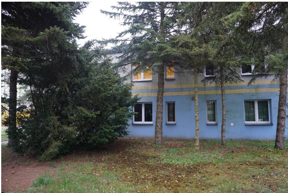
Zdjęcie nr 2 – Elewacja zachodnia – lokalizacja projektowanego szybu windowego
