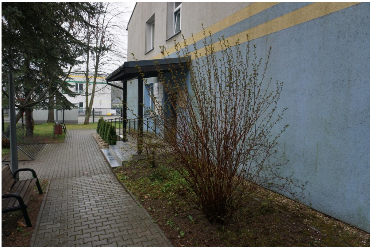
Zdjęcie nr 1 – Wejście główne do budynku z istniejącą pochylnią
