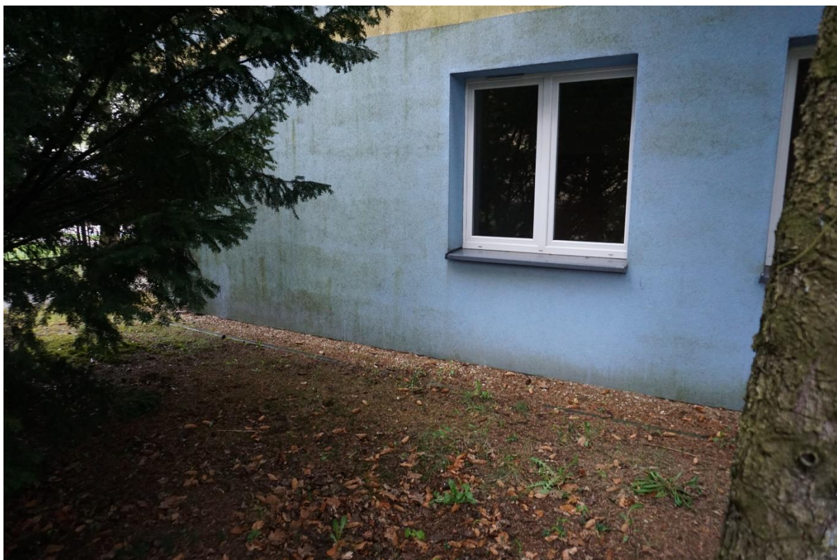
Zdjęcie nr 3 – Okno do przebudowy na drzwi wejściowe do szybu
