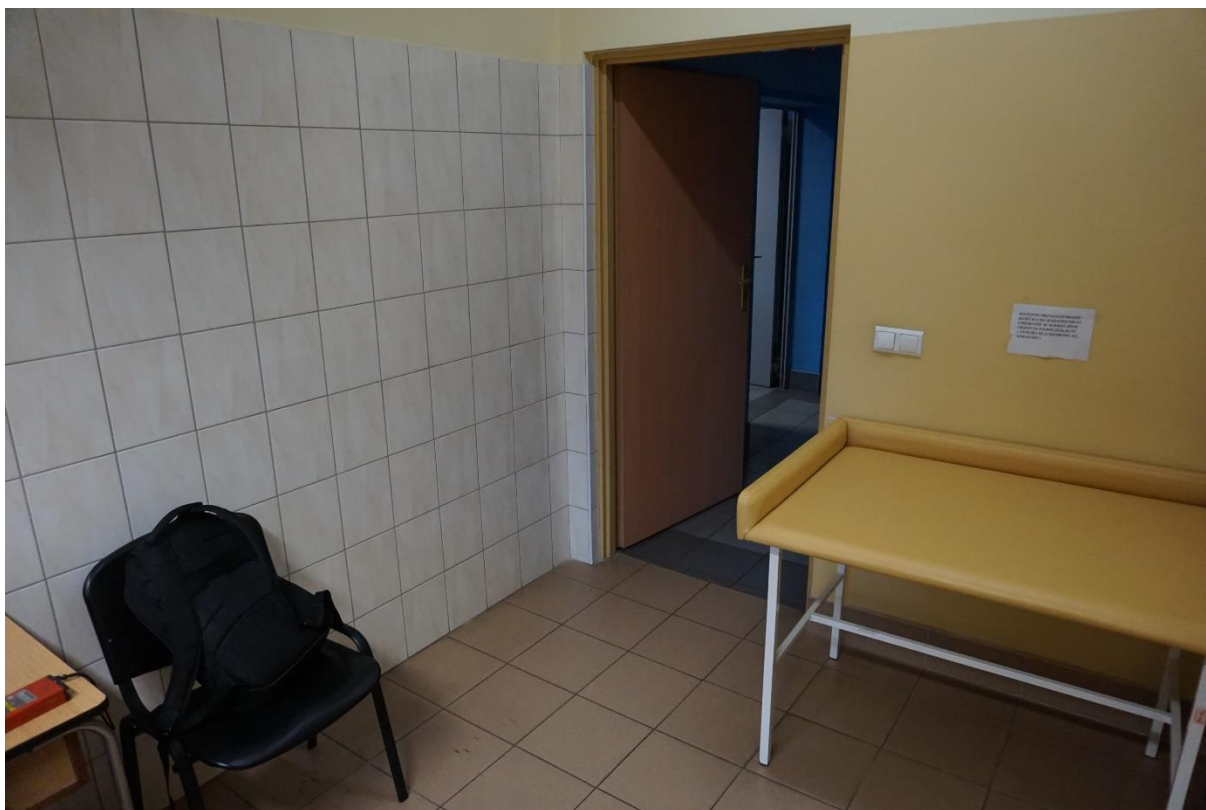
Zdjęcie nr 5 – Parter – widoczna ściana działowa do rozbiórki i ściana pokryta płytkami
