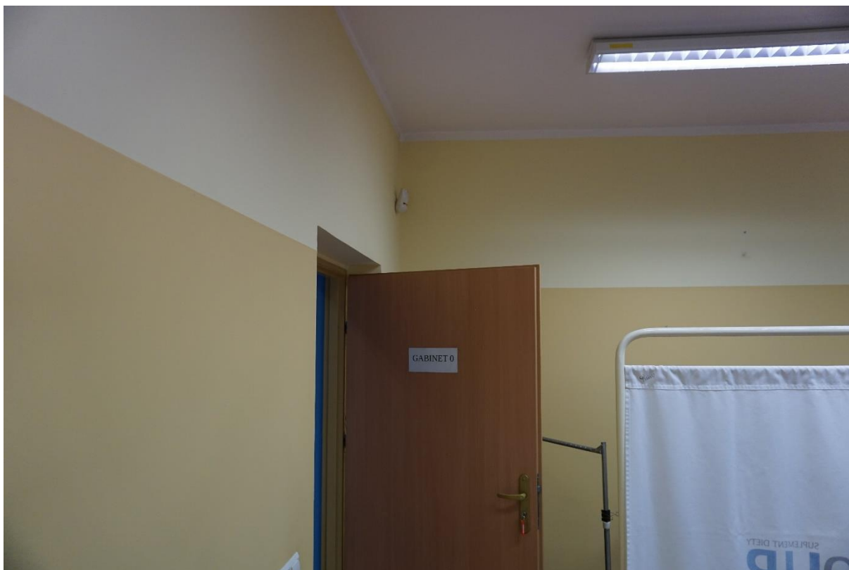
Zdjęcie nr 7 – Piętro – ściana do rozbiórki i drzwi do archiwum
