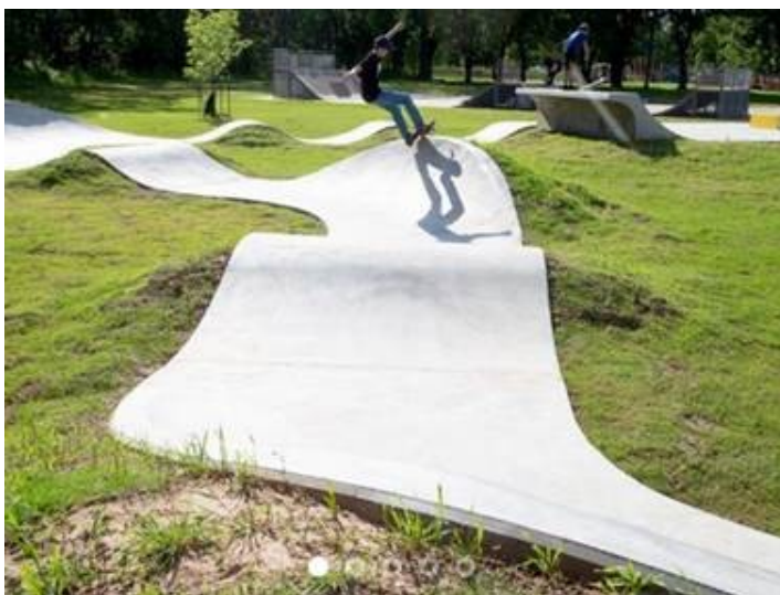
Fot. 1. Coping na betonowym pumptracku
