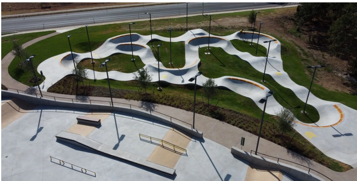
Fot.2 Betonowy pumptrack z copingami oraz jumpboxem do skoków”
