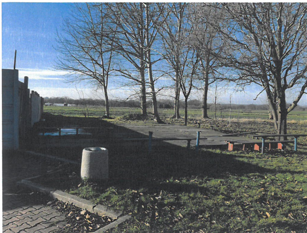
Fot. 1 Widok istniejącego utwardzenia i zagospodarowania terenu
