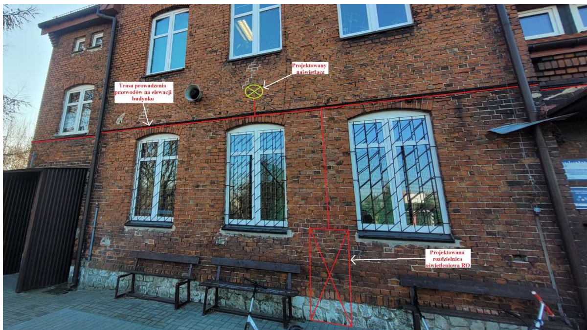
Rys. 3.2 Proponowane usytuowanie RO, naświetlacza oraz prowadzenia przewodów na elewacji
