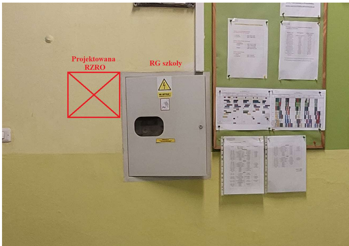
Rys. 3.1 Proponowane usytuowanie RZRO (rozmiar RZRO na rysunku nie jest obligatoryjny)
