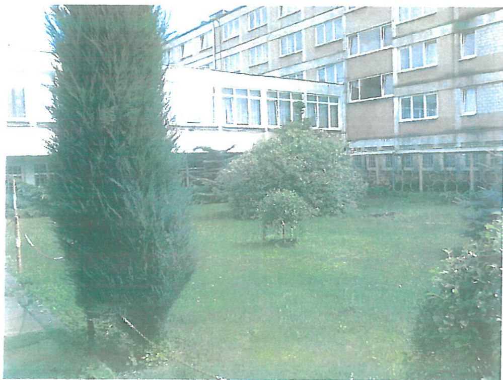
Zdjęcie 4 Teren przy budynku internatu z krzewami liściastymi i iglastymi (poz. inw. 61-68) przeznaczonymi do usunięcia
