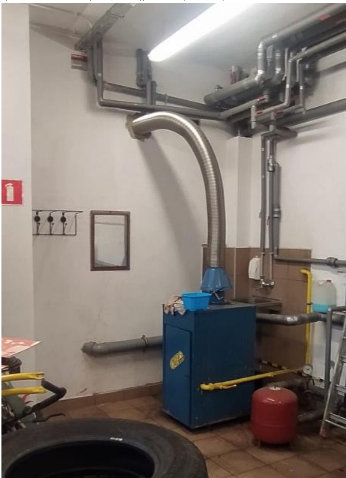
Wymiennikownia – dot. wymiany rurociągu kanalizacji sanitarnej PVC 110
