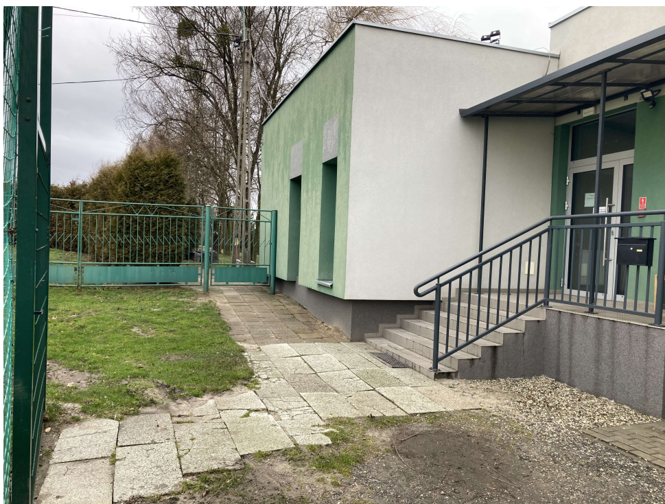
Fot. 3 Widok planowanego miejsca utwardzenia terenu – od strony bocznego boiska trawiastego (po prawej budynek LKS, po lewej piłkochwyty boiska trawiastego, na wprost furka i brama wjazdowa prowadząca na główne boisko trawiaste)
