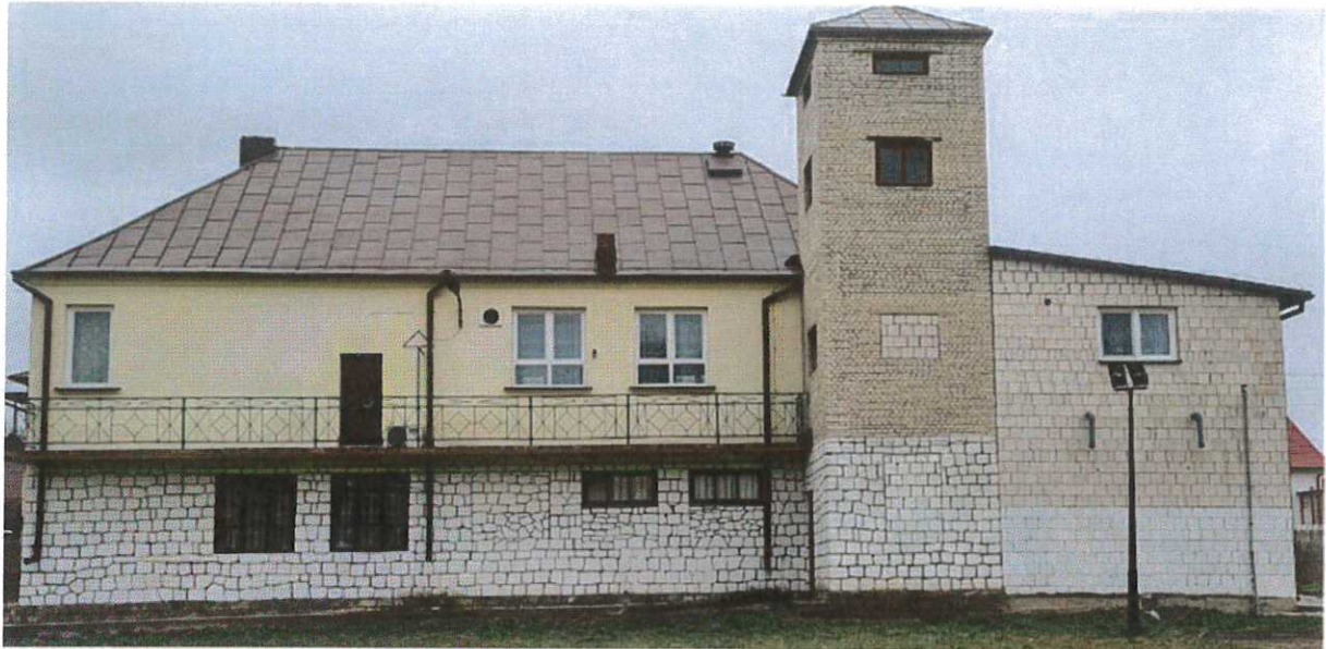
Elewacja tylna, wschodnia
