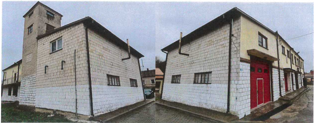
Elewacja boczna, północna
