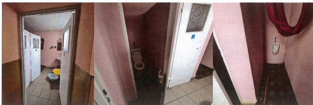
Toaleta na piętrze
