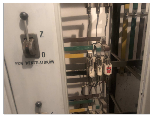
POŁĄCZENIA NA SZYNACH NALEŻY WYKONAC LINKĄ (min.) LGy 35mm 2 ZA POMOCĄ ZACISKU DO SZYN ZBIORCZYCH 1,5-35mm 2
