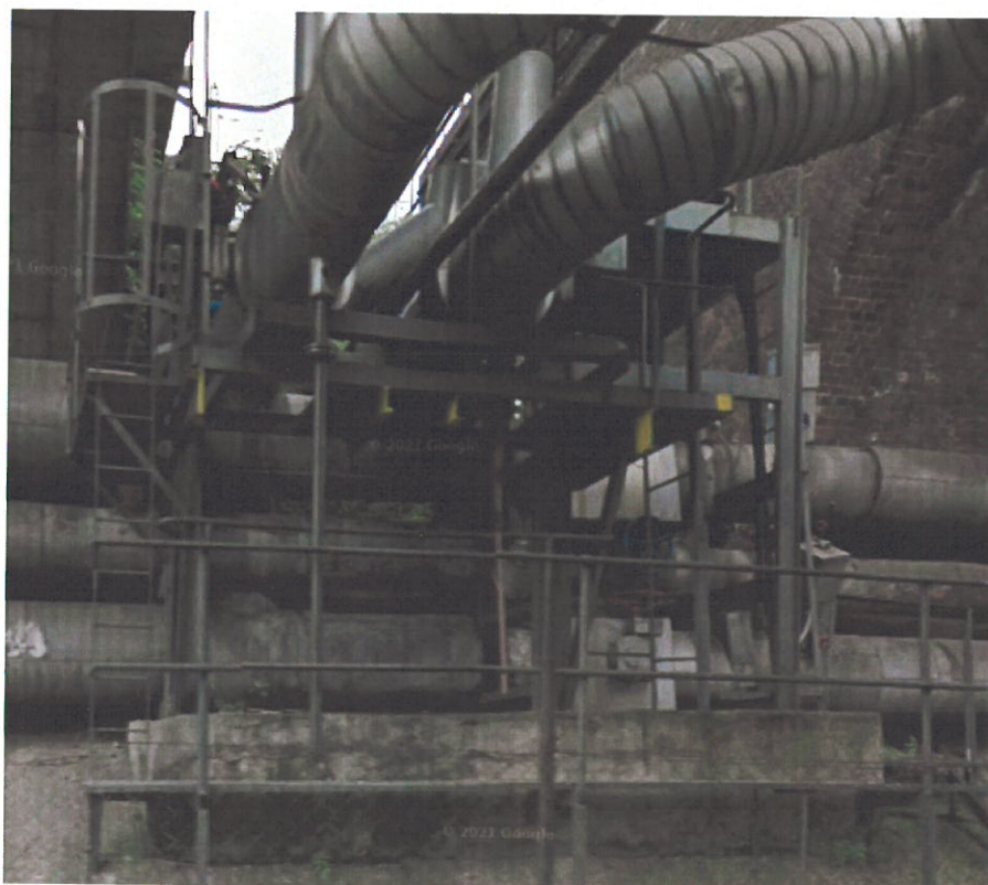
Fot. 24 Komora K-2.
