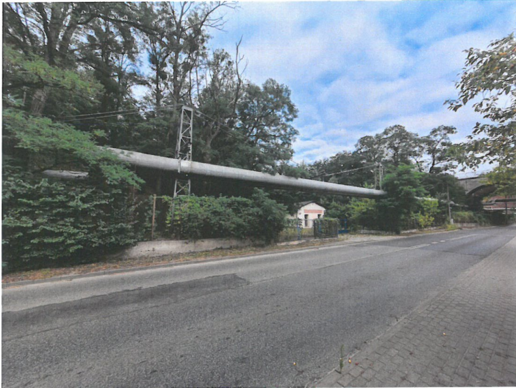
Fot. 21 Podpora nr 15 (po lewej) podpora nr 16 (po prawej).
