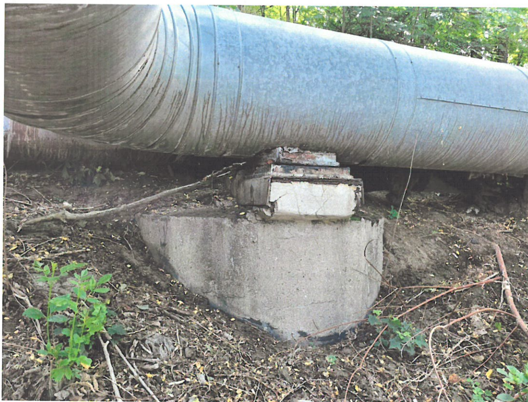
Fot. 15 Podpora nr 13.
