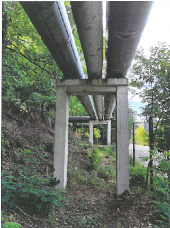
Fot. 13 Podpora nr 11.
