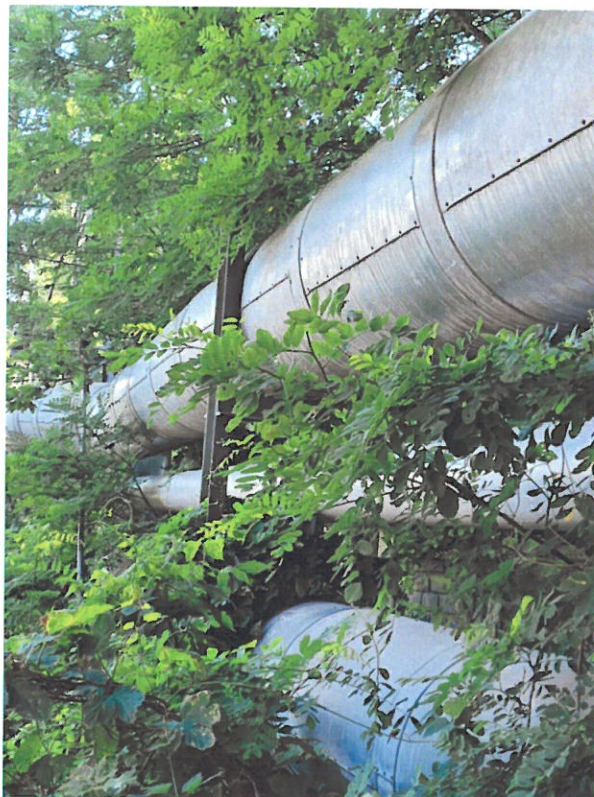
Fot. 23 Podpora nr 18.
