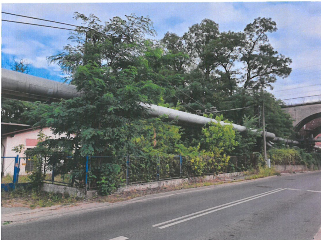
Fot. 22 Podpora nr 16 (po lewej) podpora nr 17 (po prawej).
