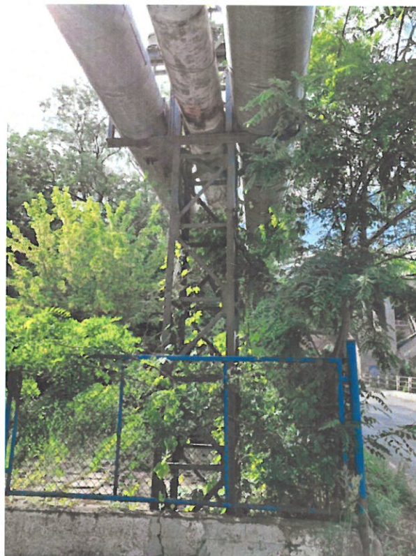
Fot. 19 Podpora nr 16.
