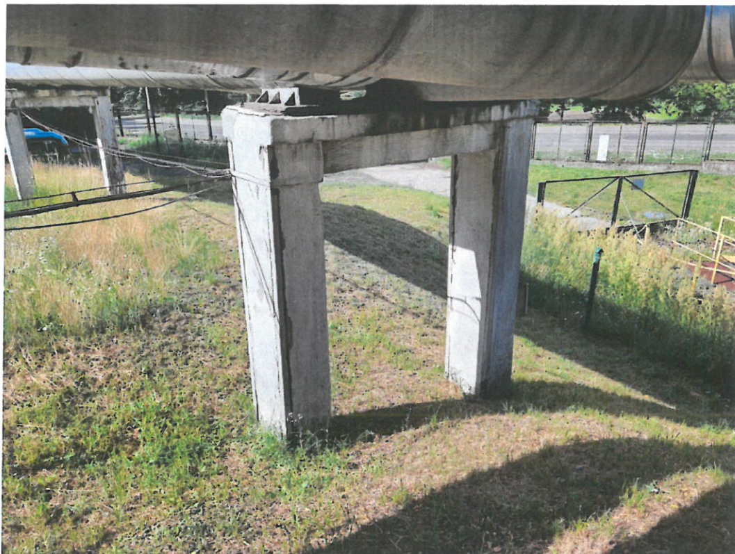
Fot. 5 Podpora nr 3.
