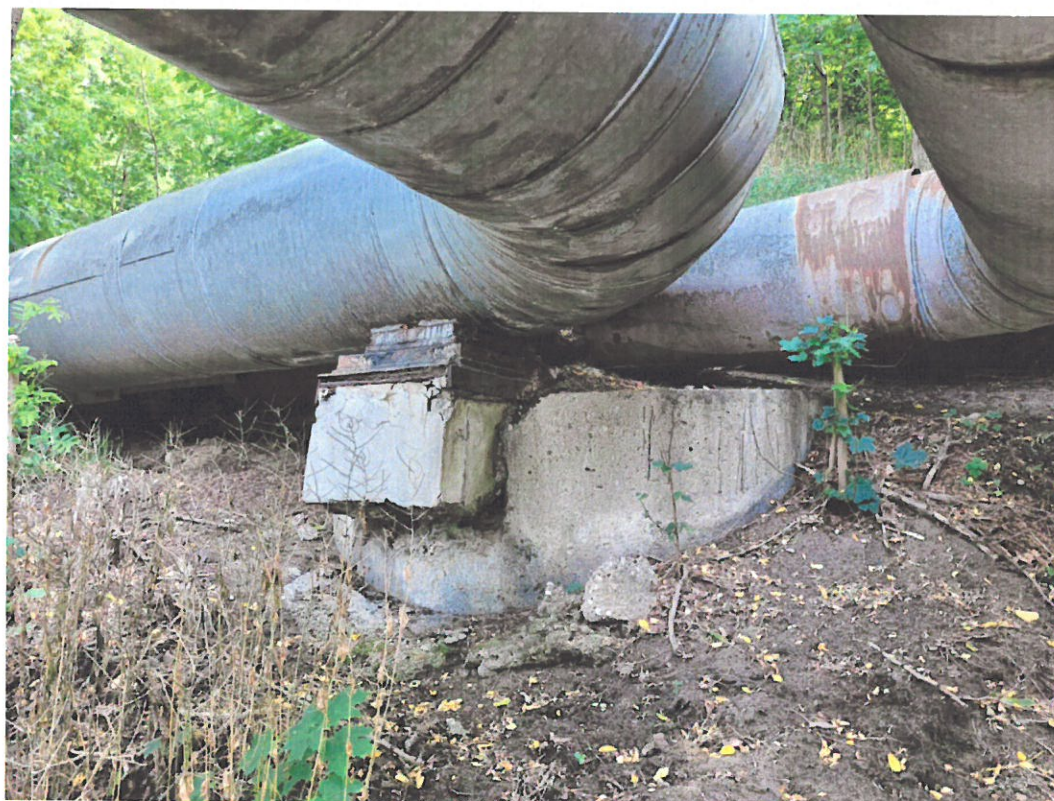
Fot. 16 Podpora nr 14.
