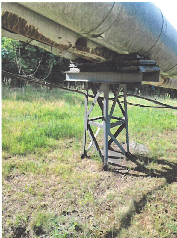
Fot. 3 Podpora nr 1.
