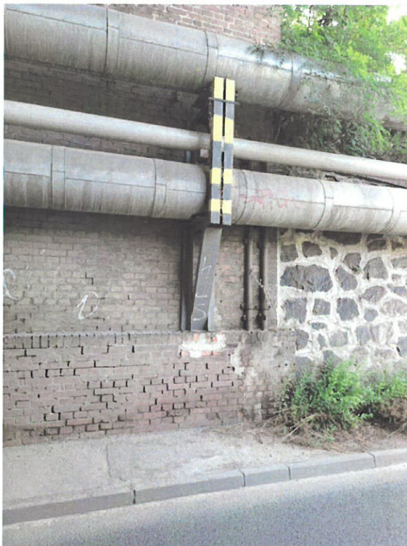
Fot. 31 Podpora nr 25.
