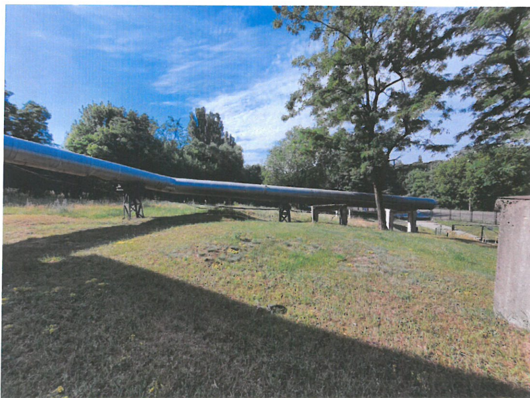
Fot. 2 Widok na odcinek na terenie EC I.
