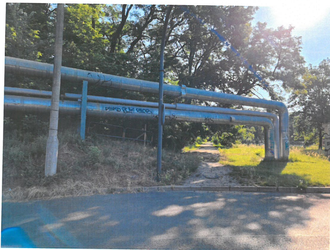
Fot. 34 Widok na podporę nr 27 i zakończenie części napowietrznej ciepłociągu.
