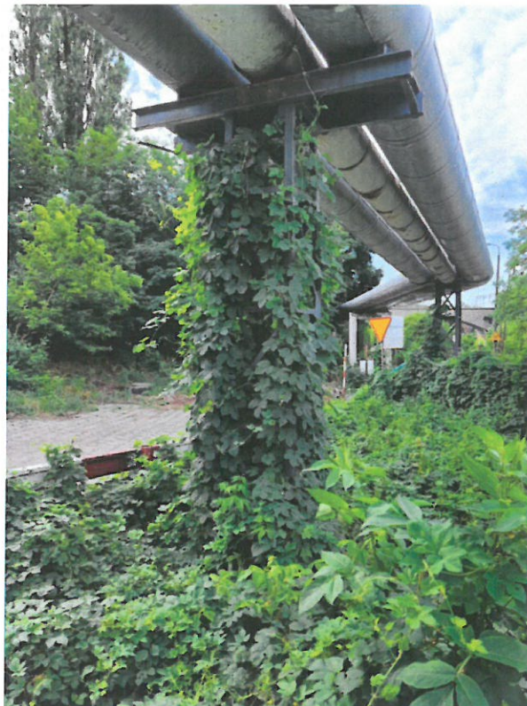
Fot. 9 Podpora nr 7.
