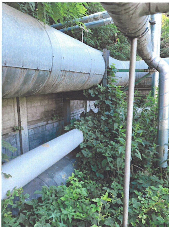
Fot. 27 Podpora nr 21.
