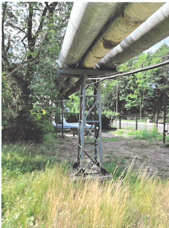
Fot. 7 Podpora nr 5.
