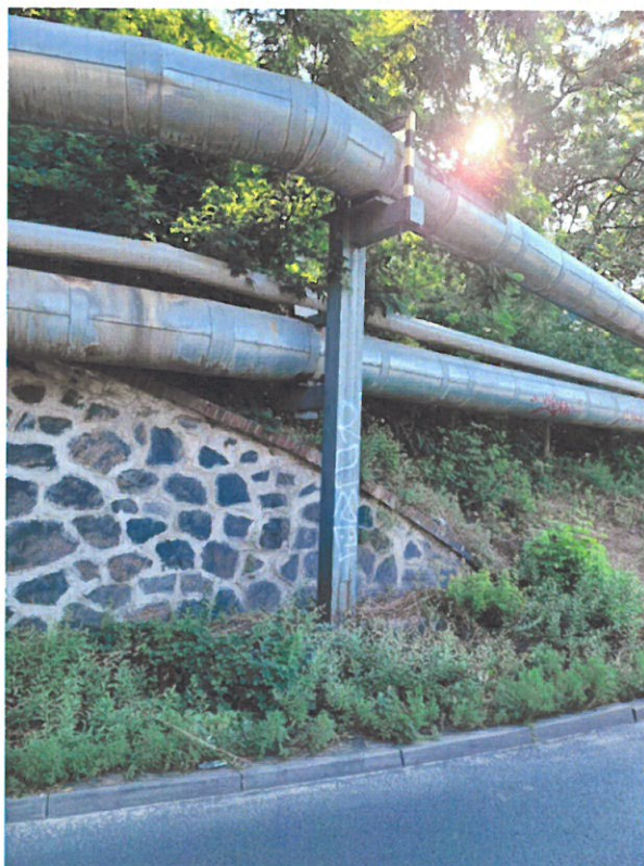
Fot. 32 Podpora nr 26.
