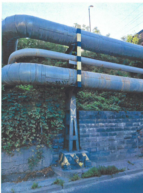
Fot. 28 Podpora nr 22.
