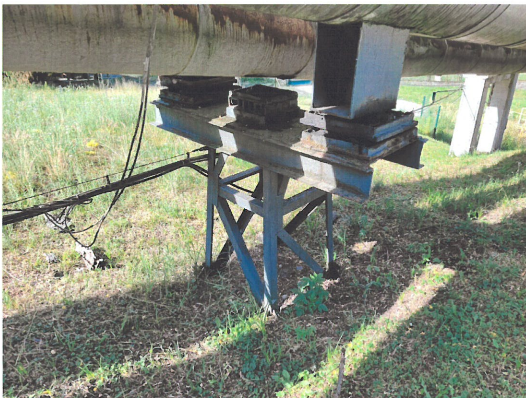
Fot. 4 Podpora nr 2.
