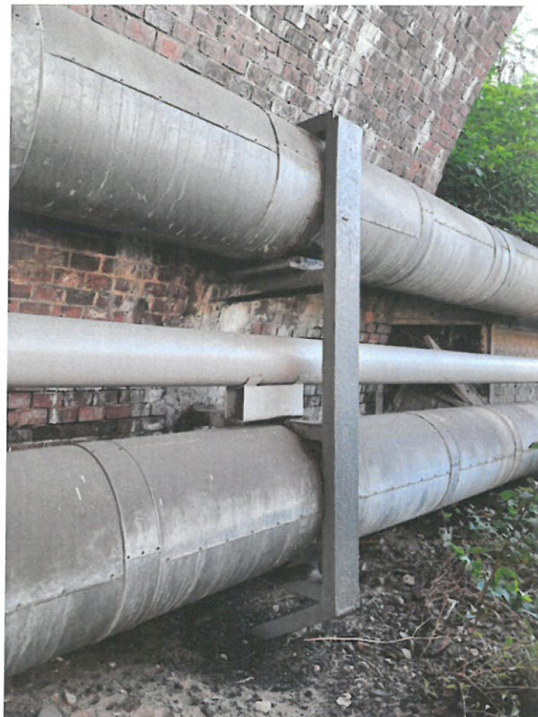
Fot. 25 Podpora nr 19.
