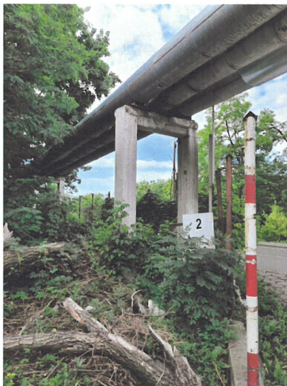
Fot. 11 Podpora nr 9.
