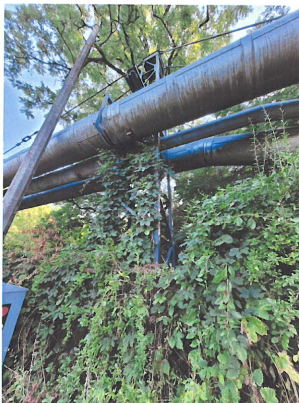
Fot. 20 Podpora nr 17.
