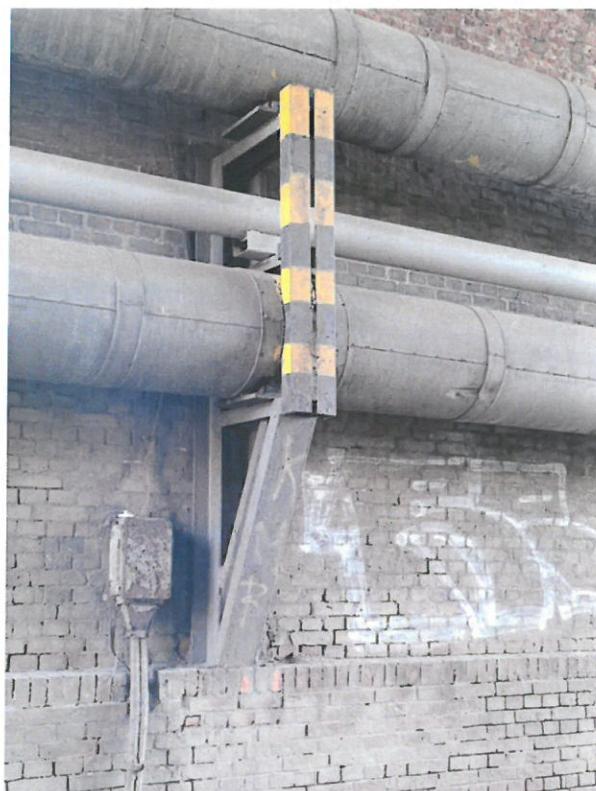
Fot. 30 Podpora nr 24.
