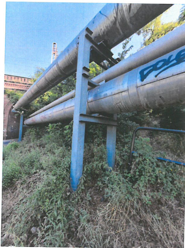
Fot. 33 Podpora nr 27.
