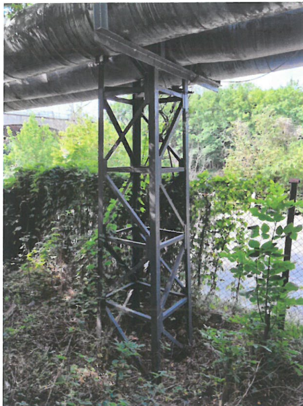
Fot. 17 Podpora nr 15.
