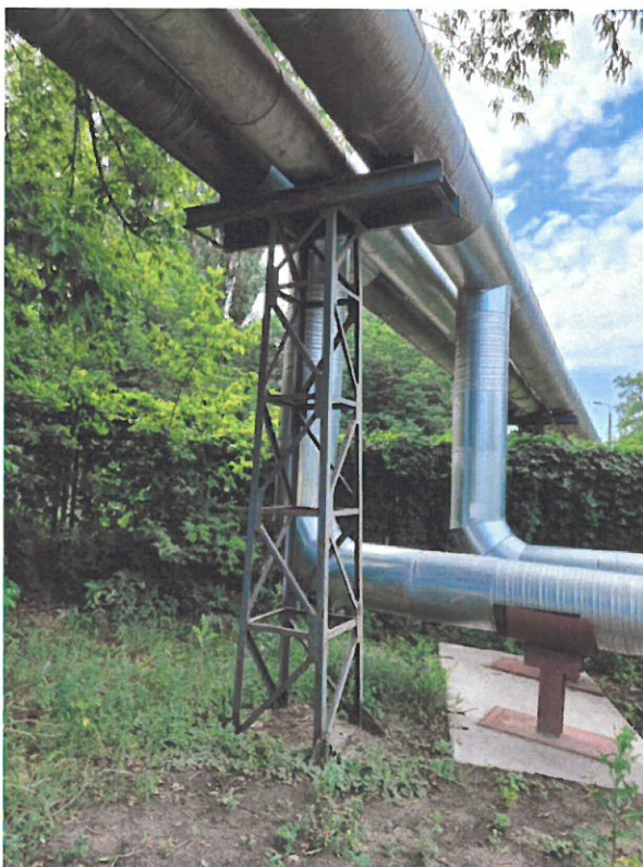
Fot. 8 Podpora nr 6.
