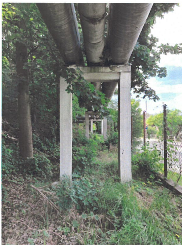
Fot. 12 Podpora nr 10.
