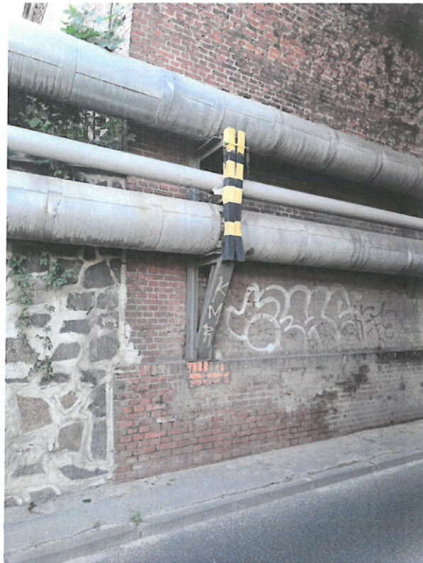
Fot. 29 Podpora nr 23.
