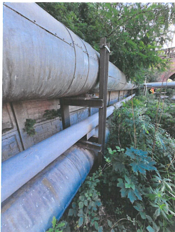
Fot. 26 Podpora nr 20.
