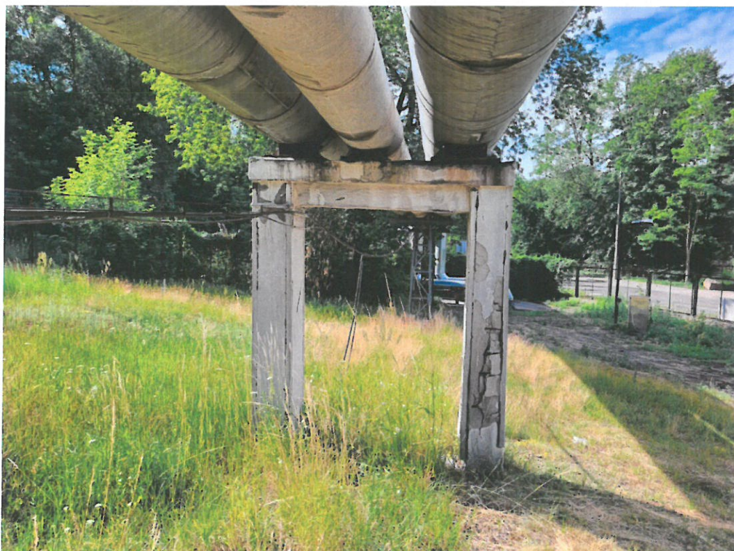
Fot. 6 Podpora nr 4.
