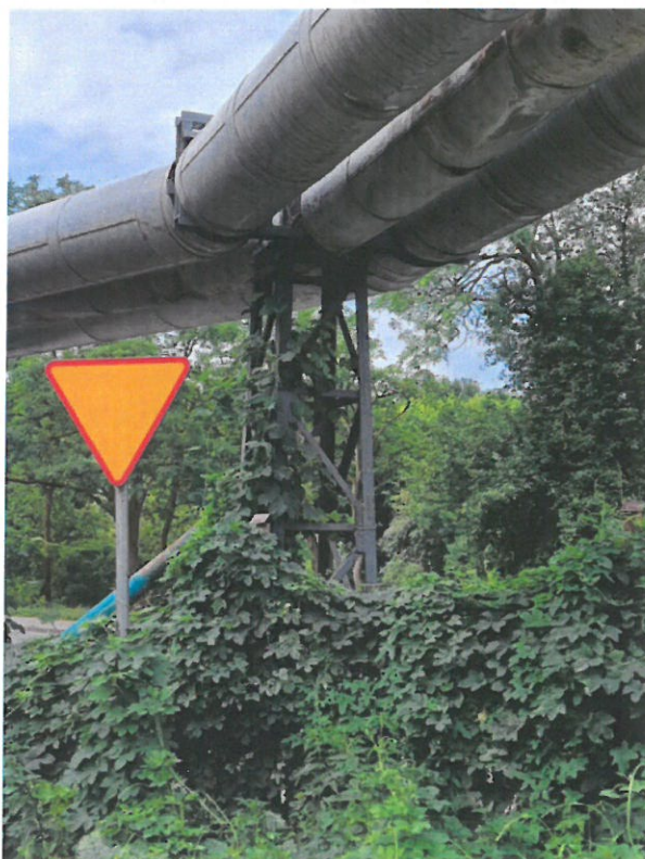
Fot. 10 Podpora nr 8.
