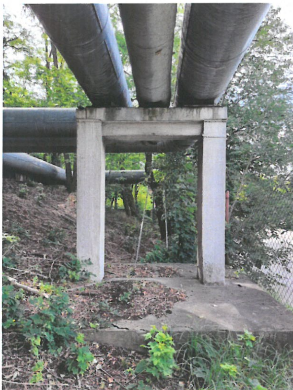
Fot. 14 Podpora nr 12.
