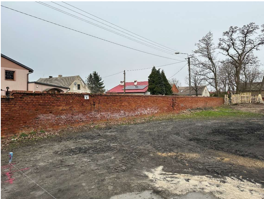
6. Widok ogrodzenia od strony zachodniej (strona dziedzina). Stan z dnia 21.03.2024r. Widoczne ubytki cegieł, wypłukanie spoin oraz wykwyty soli w dolnej partii muru.
