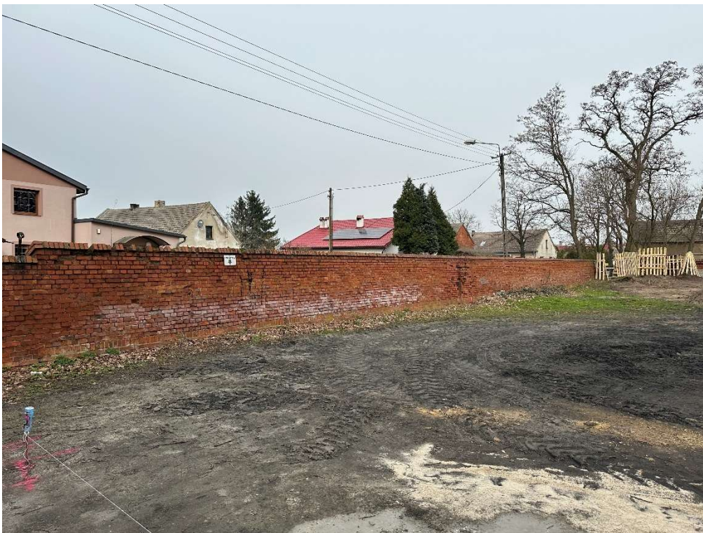
6. Widok ogrodzenia od strony zachodniej (strona dziedzińca). Stan z dnia 21.03.2024r. Widoczne ubytki cegieł, wypłukanie spoin oraz wykwyty soli w dolnej partii muru.
