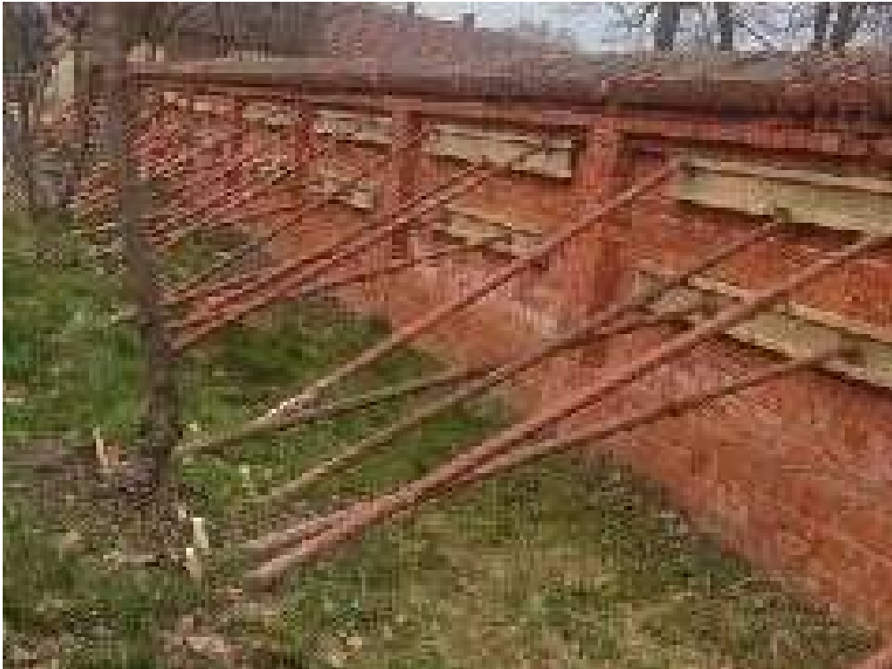
3. Widok ogrodzenia od strony zachodniej. Stan z dnia 21.03.2024r. Konieczność zastosowania podpór podtrzymujących mur.
