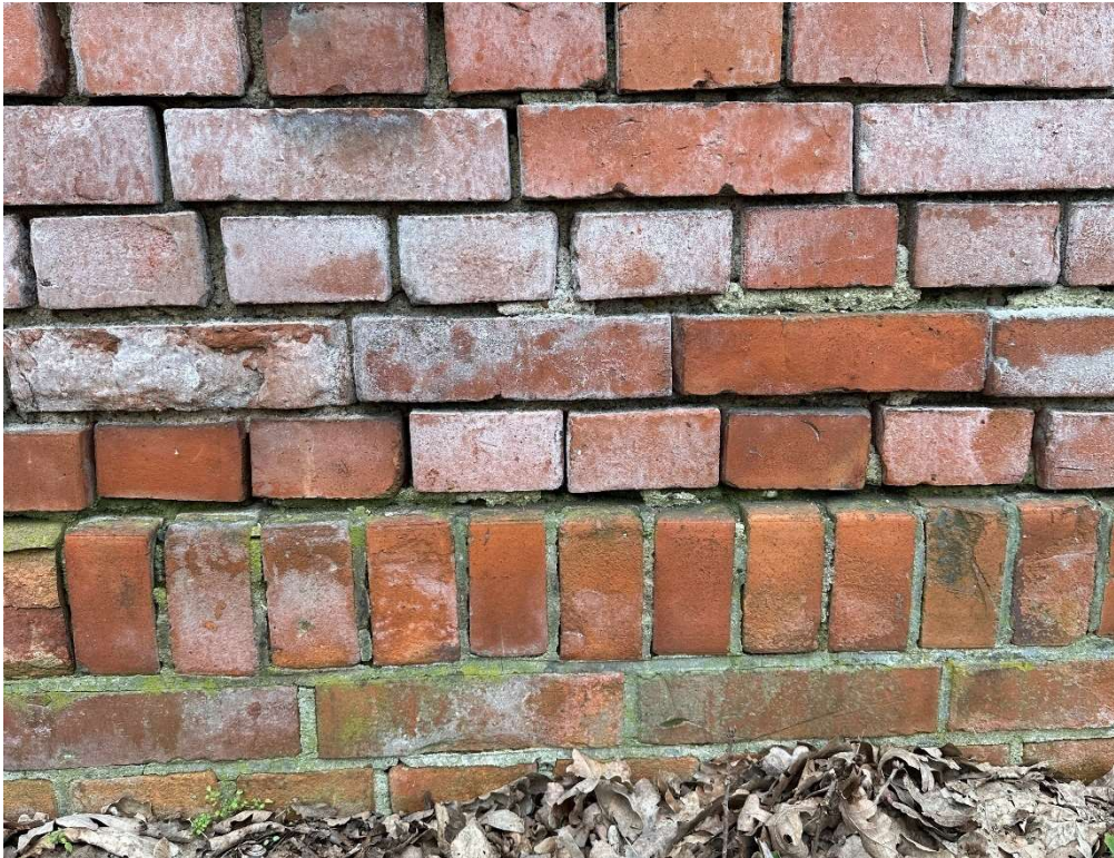
4. Widok ogrodzenia od strony zachodniej (strona dziedzińca). Stan z dnia 29.03.2024r. Widoczne wypłukanie spoin oraz wykwyty soli w dolnej partii muru.
