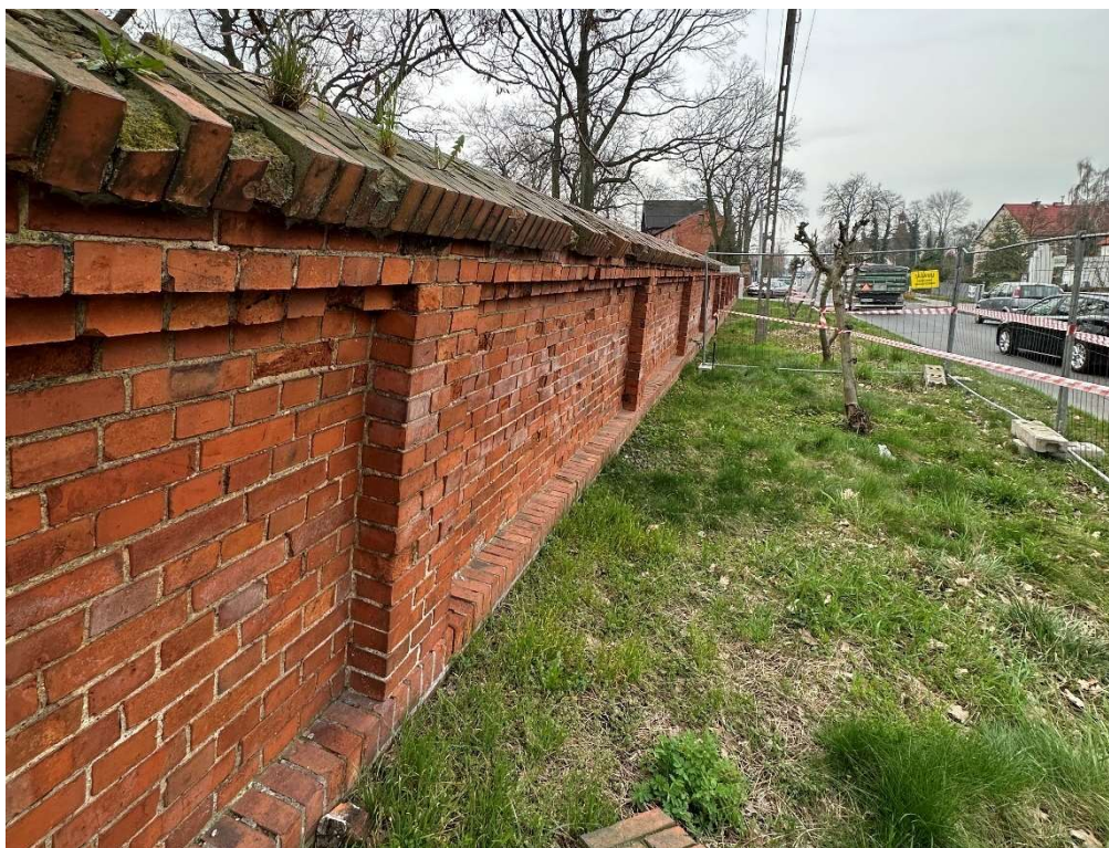
2. Widok ogrodzenia od strony zachodniej (od strony ul. Jesiennej). Stan z dnia 21.03.2024r. Stan przed wprowadzeniem podpór. Widoczne odchylenia muru w kierunku ulicy.
