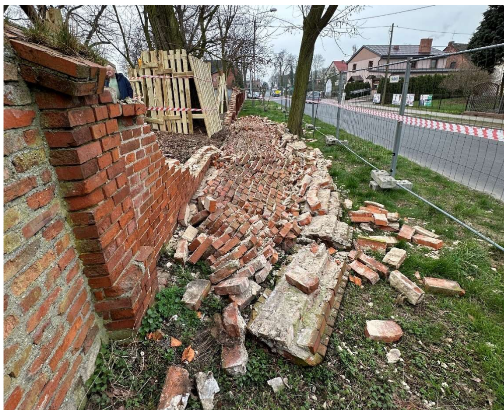
1. Widok ogrodzenia od strony zachodniej. Stan z dnia 21.03.2024r. fragment zawalonego muru przy północnej granicy działki.
