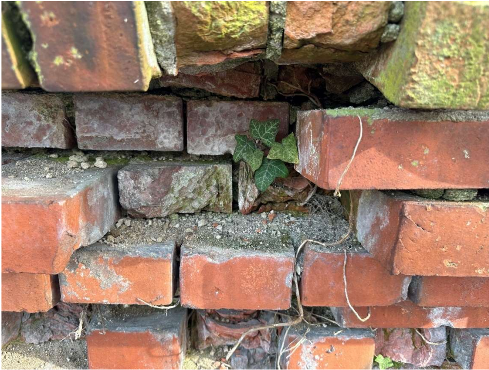
5. Widok ogrodzenia od strony zachodniej (strona dziedzińca). Stan z dnia 29.03.2024r. Widoczna korozja biologiczna, będąca przyczyną dezintegracji budulca muru.
