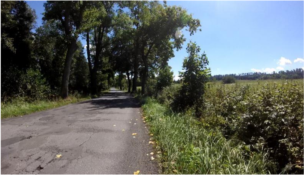
Zdj. nr 3 Środkowa część projektowanego odcinka
