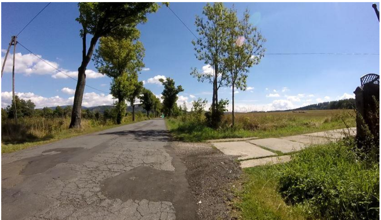
Zdj. nr 2 Początkowy odcinek drogi
