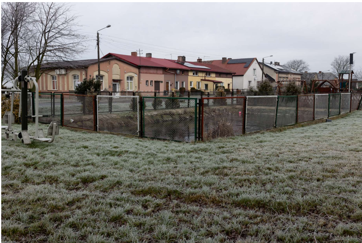
Zbiornik p.poż. na odcinku 2
