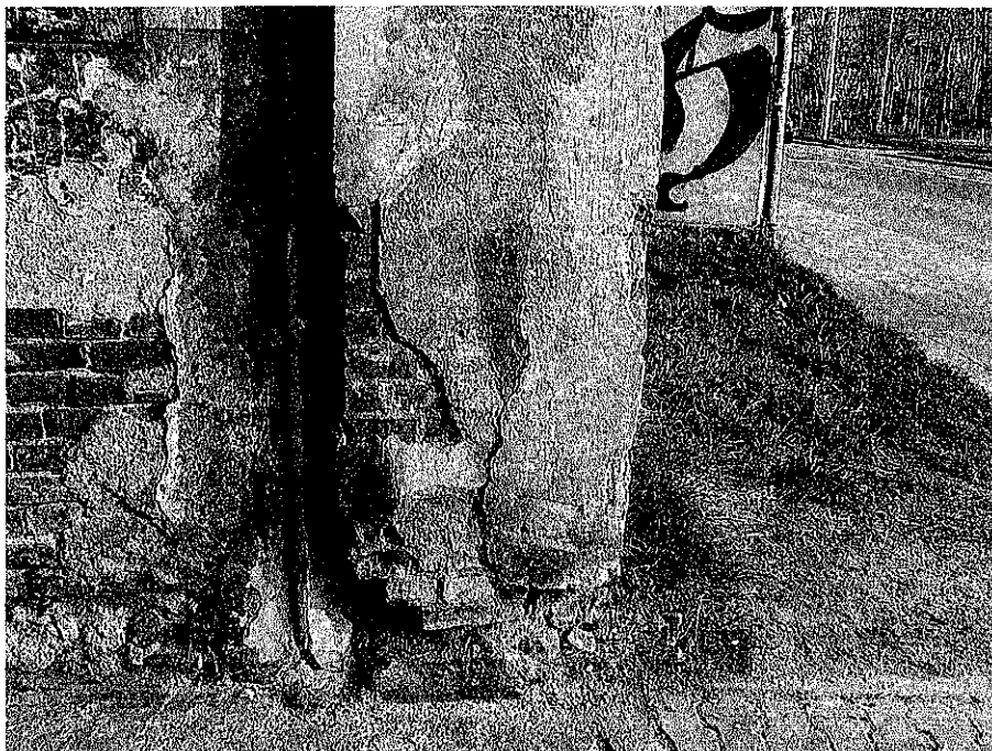
Fot.5 Filar F2-w strefie - przyziemia widoczne uszkodzenia.
