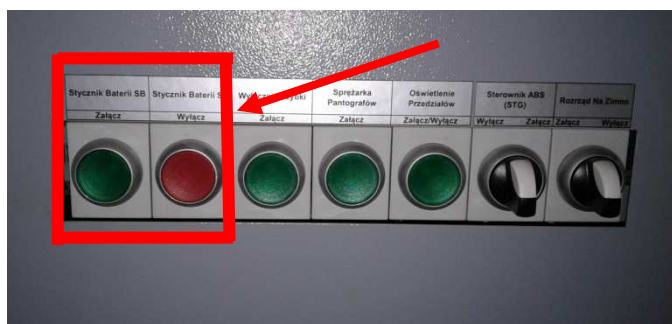
Rys.2 Widok tablicy w szafie NN z zaznaczonymi przyciskami zał. i wył. baterii.
