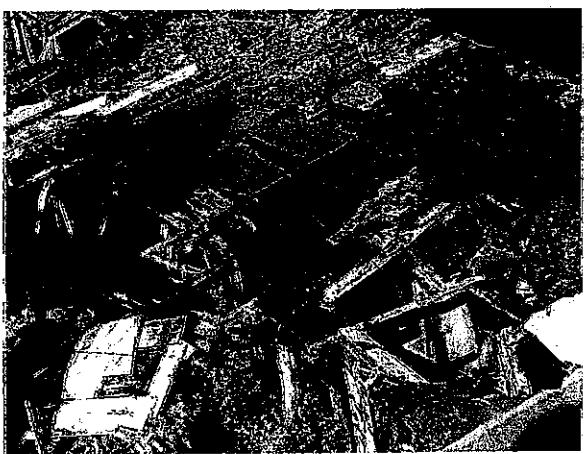
Zarwany dach i ściana tylna budynku gospodarczego od strony Wólczańskiej 147a.
