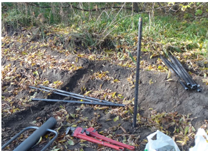
Fot. 3 Sonda gazowa przed instalacją
