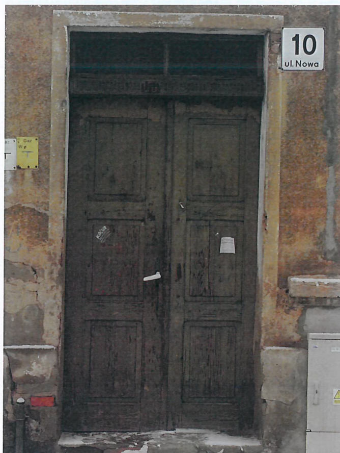
Fot. 4 Widok drzwi wejściowych do budynku.
