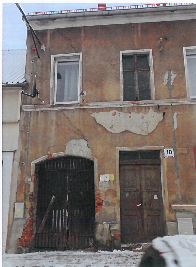
Fot. 3 Widok drzwi wejściowych i przejazdu.
