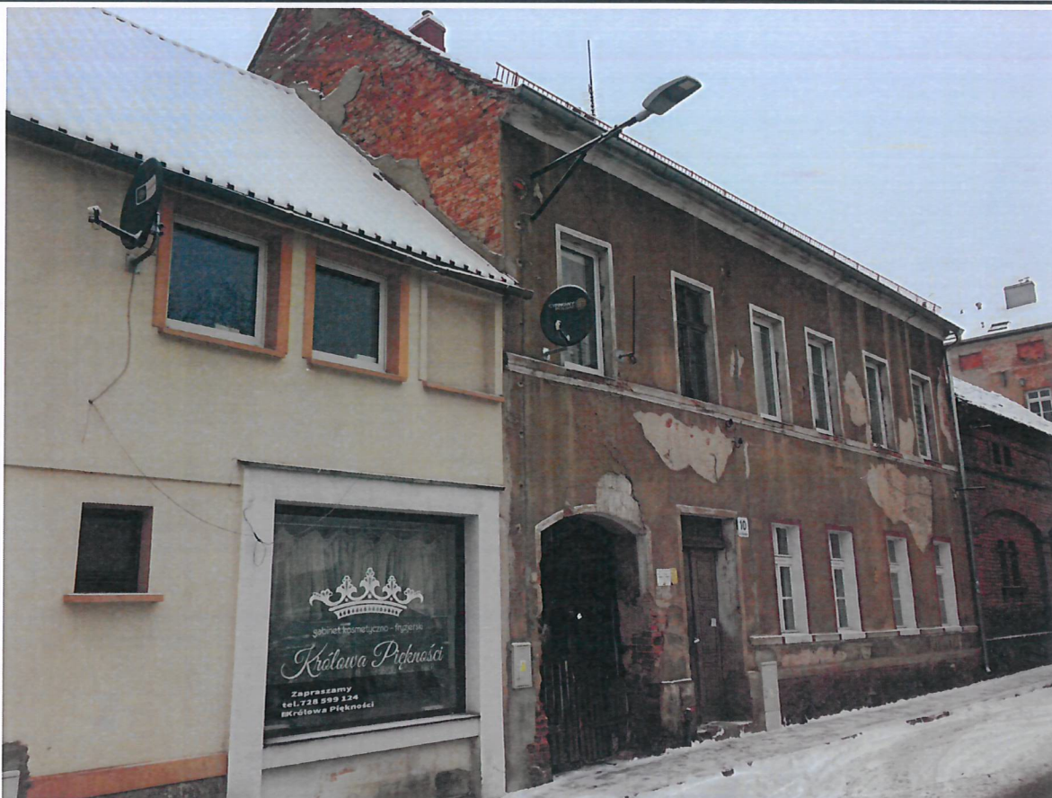
Fotografia nr 1 Widok elewacji frontowej (wschodniej).
