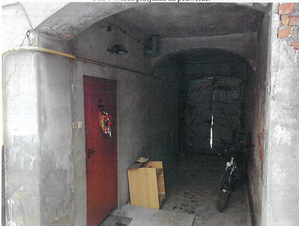
Fot. 8 Widok przejazdu na podwórze.
