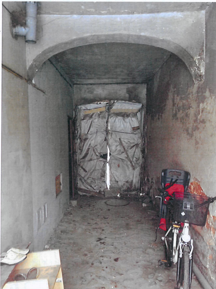
Fot. 7 Widok przejazdu na podwórze.
