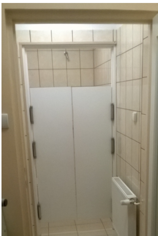
Zdjęcie nr 2 - Przykład zastosowania przesłony z drzwiczek kowbojskich w pomieszczeniu sanitarnym
