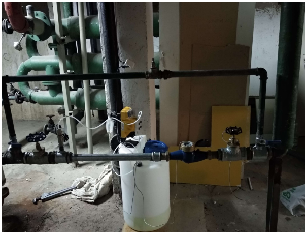
Zdjęcie 9 – Widok stacji dozującej podchloryn sodu
