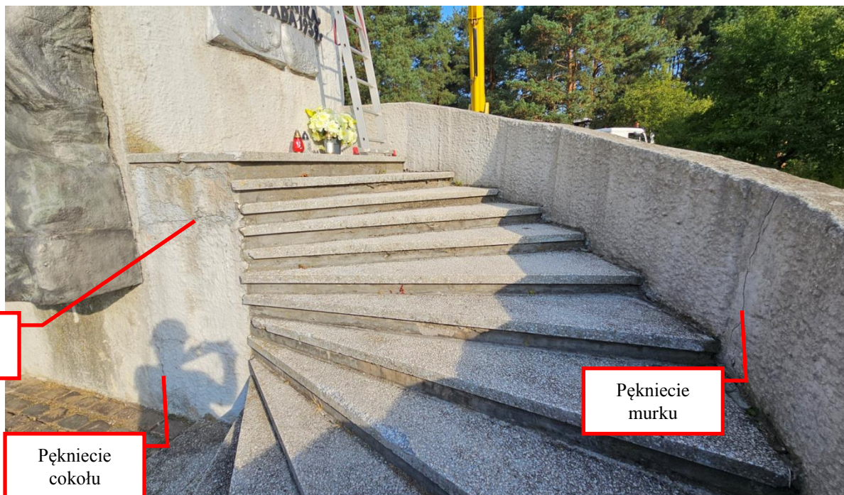
Fot. 4 Spękania na cokole i murku przy schodach
