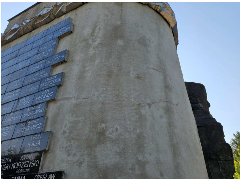
Fot. 3 Siatka zarysować na warstwie zabezpieczającej cokół
