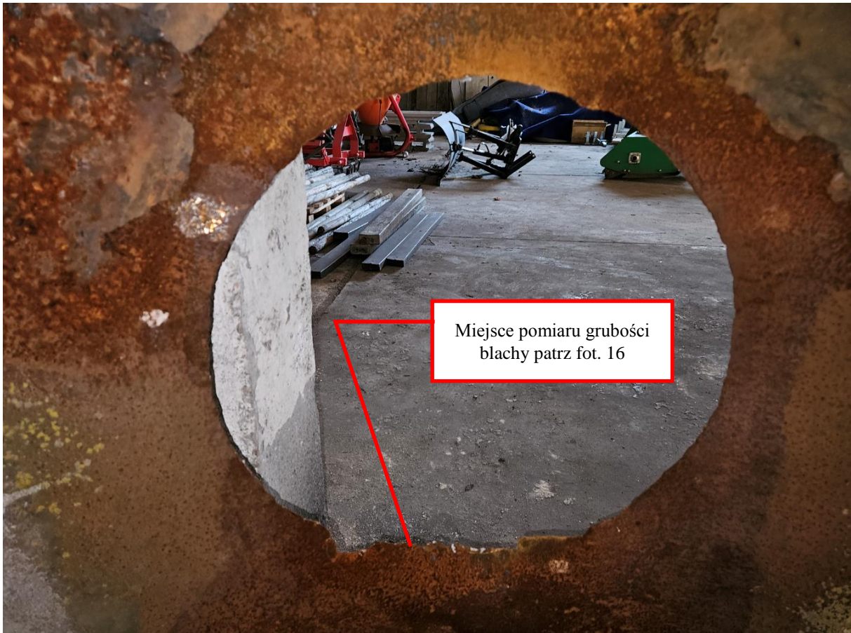
Fot. 15 Skorodowana blachy nośnej mocującej „kłos” do słupa
