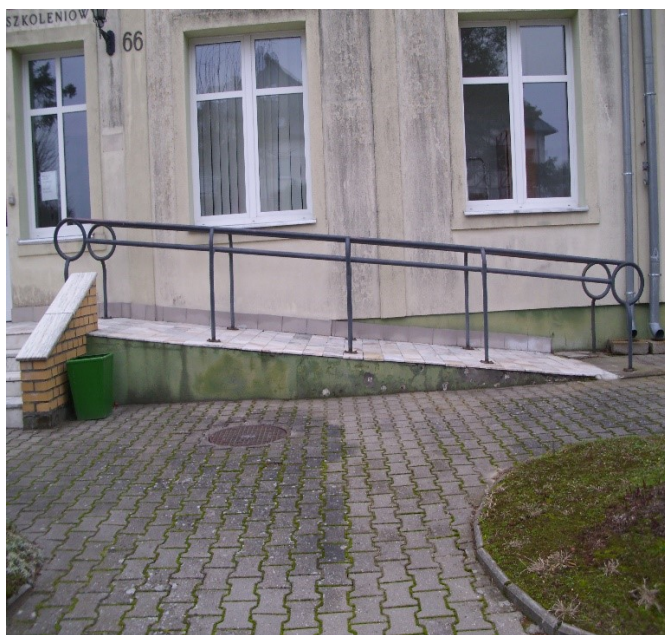
Uszkodzona faktura tynku i ocieplenia w przyziemiu-popękane płyty z piaskowca skorodowane poręcze i balustrady
