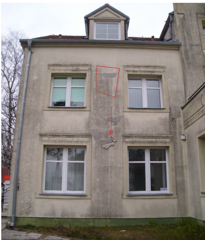
Odpadająca faktura tynku strukturalnego - porośnięte glonami i mchem ściany zewnętrzne
