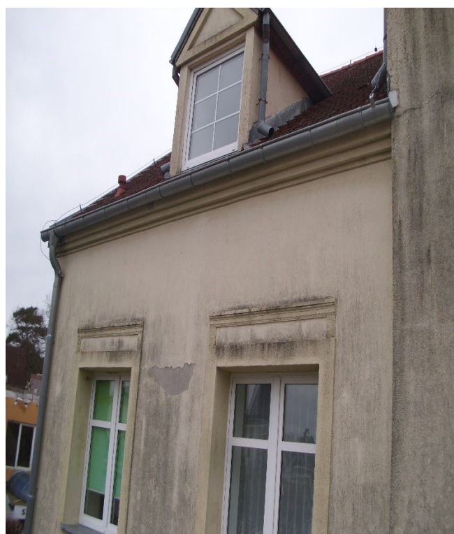
Odpadająca faktura tynku strukturalnego - porośnięte glonami i mchem ściany zewnętrzne
