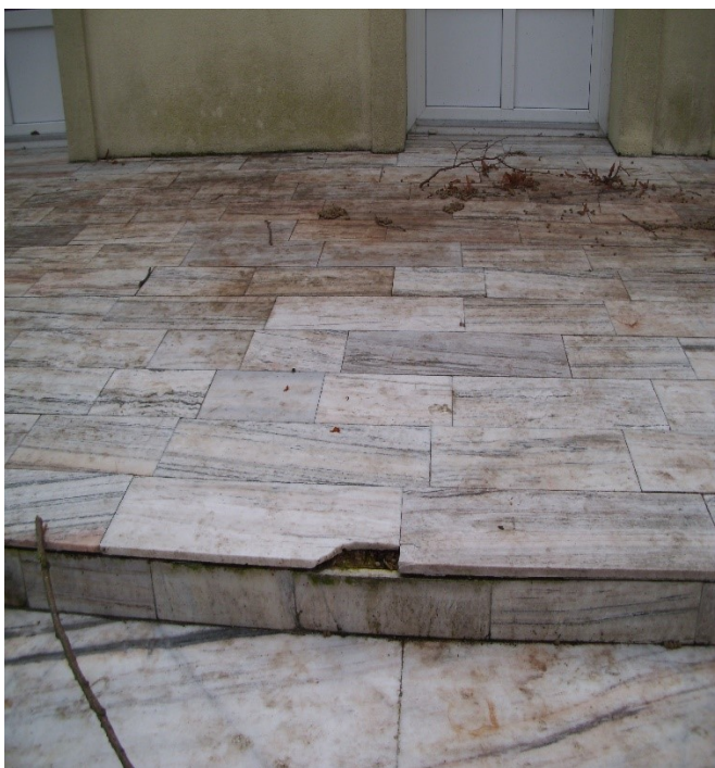
Popękane płyty z piaskowca na tarasie i schodach wejściowych
