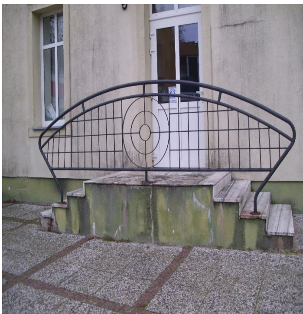
Uszkodzona faktura tynku i ocieplenia w przyziemiu-popękane płyty z piaskowca skorodowane poręcze i balustrady
