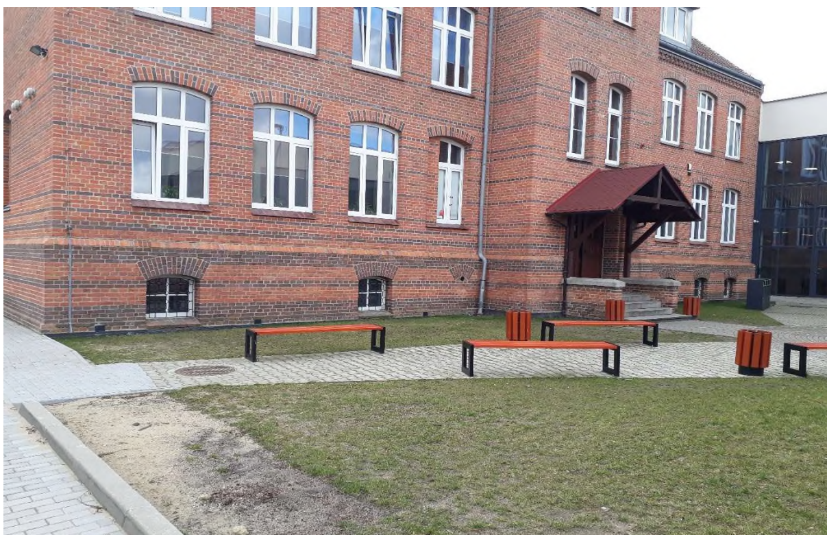
Zdjęcie nr 14 Miejsce wykonania opaski, elewacja północna – stan istniejący
