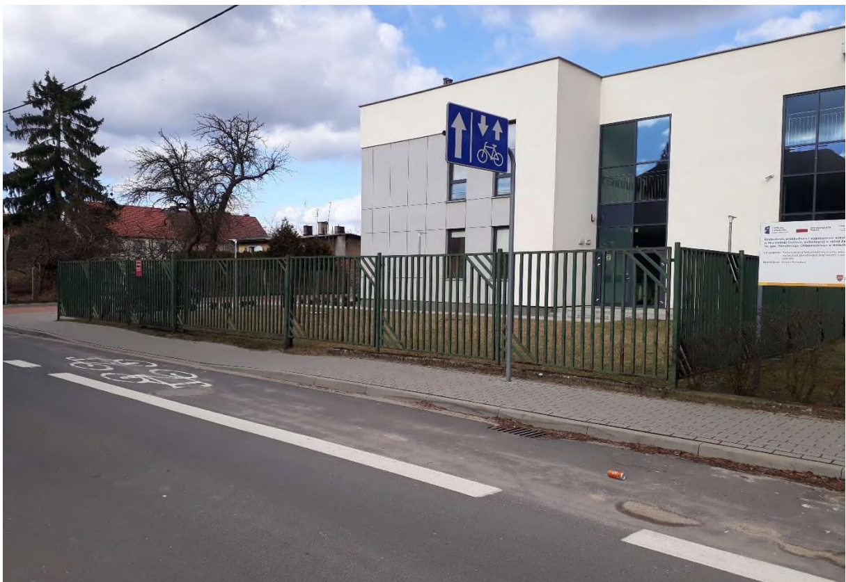
Zdjęcie nr 2 Ogrodzenie do usunięcia – stan istniejący
