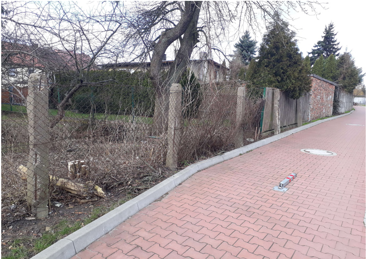
Zdjęcie nr 7 Miejsce montażu ogrodzenia typu II – stan istniejący
