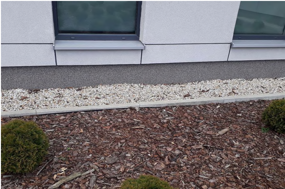
Zdjęcie nr 15 Opaska wokół budynku nowego – stan istniejący
