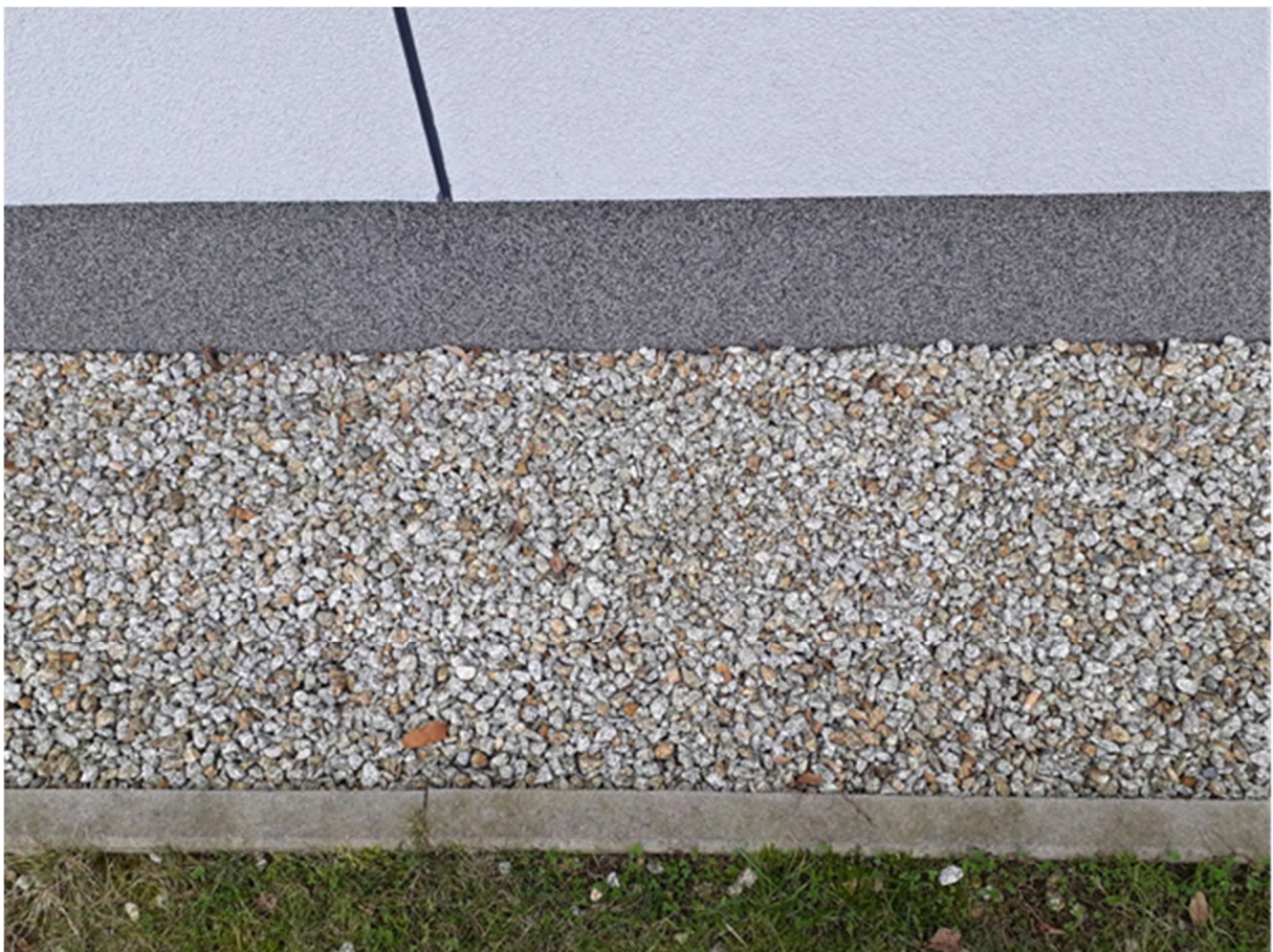
Zdjęcie nr 16 Opaska wokół budynku nowego – stan istniejący
