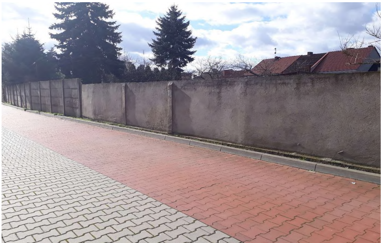
Zdjęcie nr 8 Miejsce montażu ogrodzenia typu II – stan istniejący
