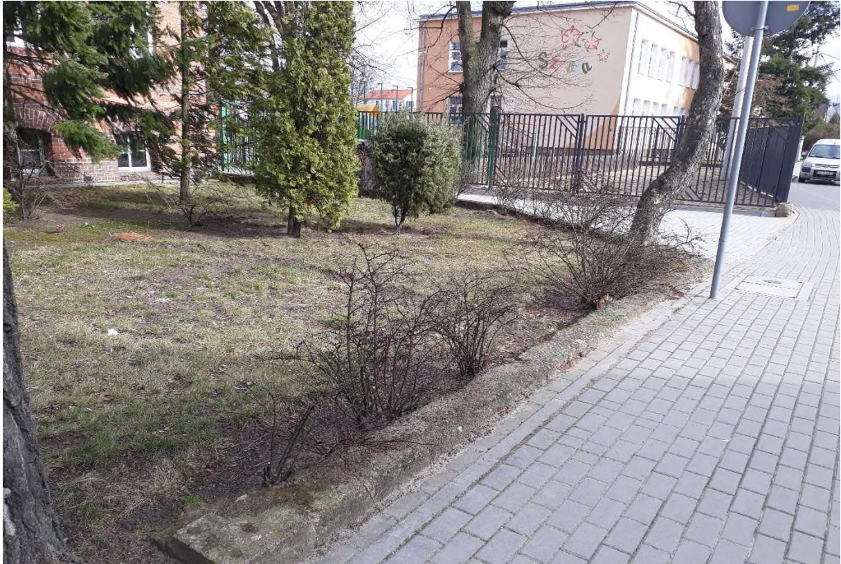
Zdjęcie nr 1 Podmurówka do usunięcia – stan istniejący
