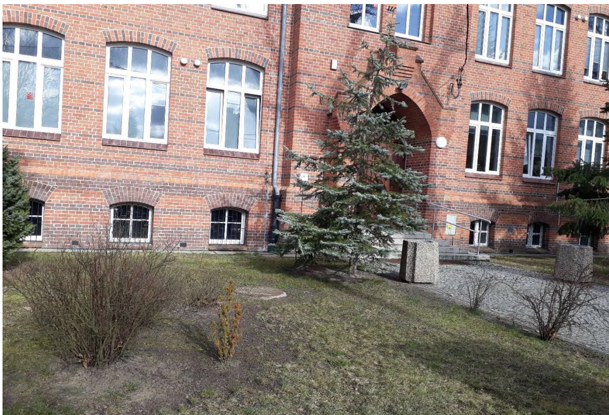
Zdjęcie nr 13 Miejsce wykonania opaski, elewacja południowa – stan istniejący
