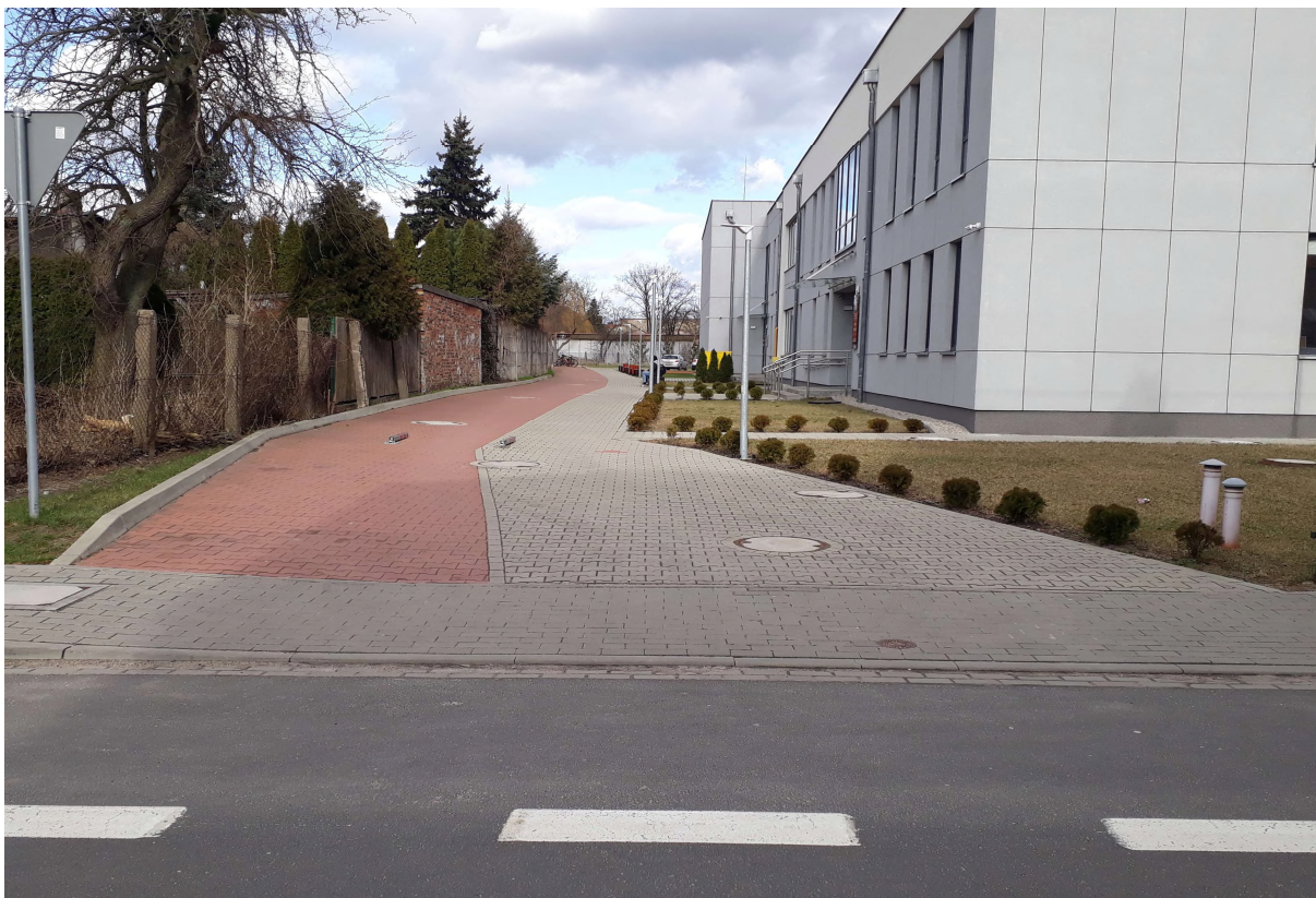
Zdjęcie nr 9 Miejsce montażu bramy przesuwnej – stan istniejący
