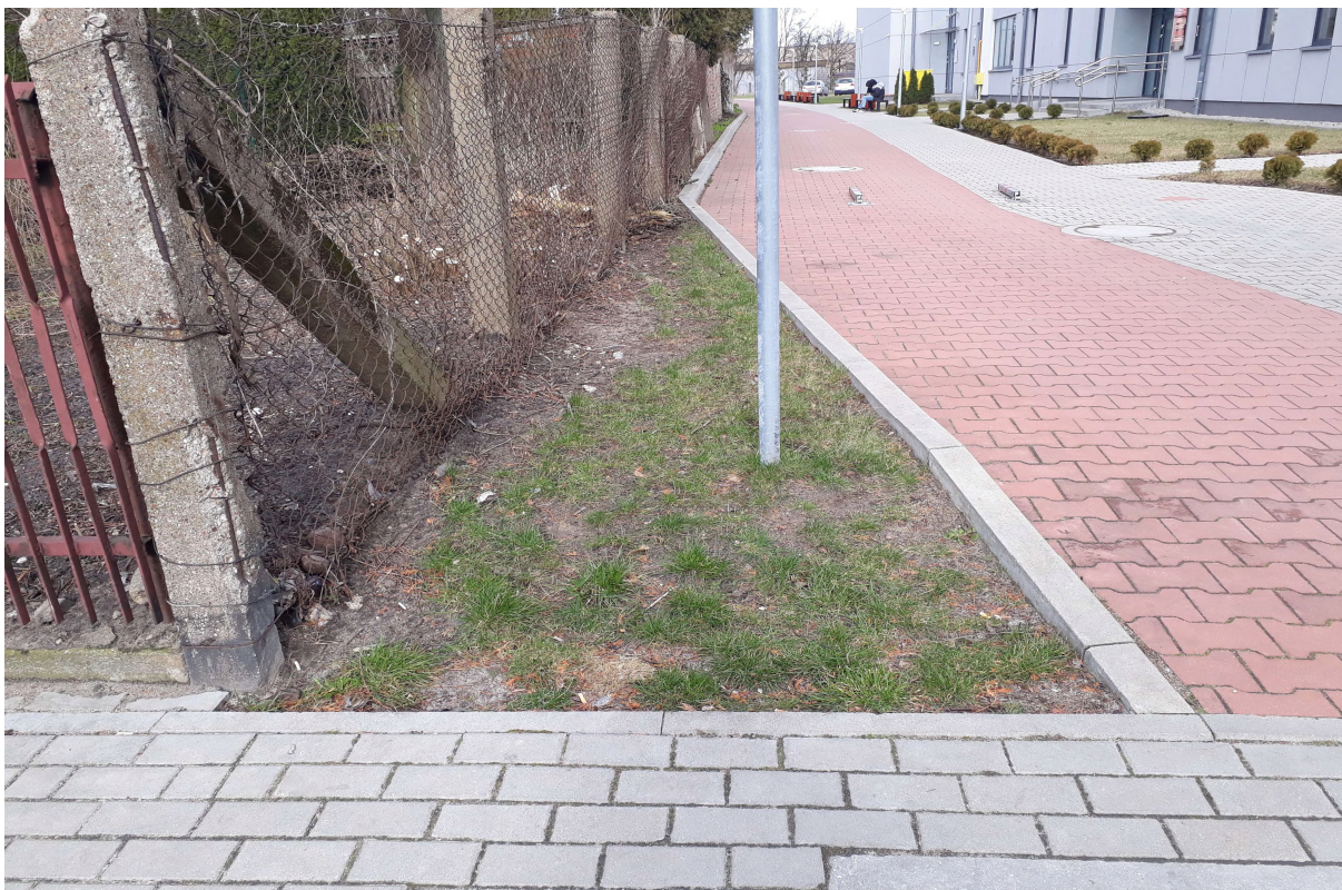
Zdjęcie nr 10 Miejsce montażu ogrodzenia typu II z ułożeniem krawężnika – stan istniejący
