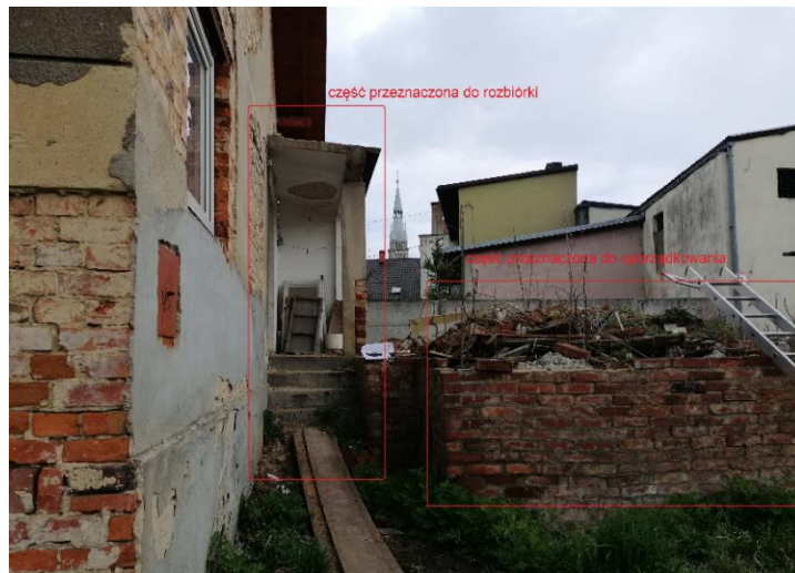
Część przeznaczona do uporządkowania i rozbiórki - elewacja wschodnia
