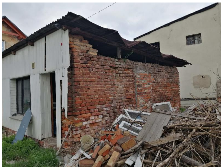
Budynek gospodarczy przeznaczony do rozbiórki - elewacja wschodnia
